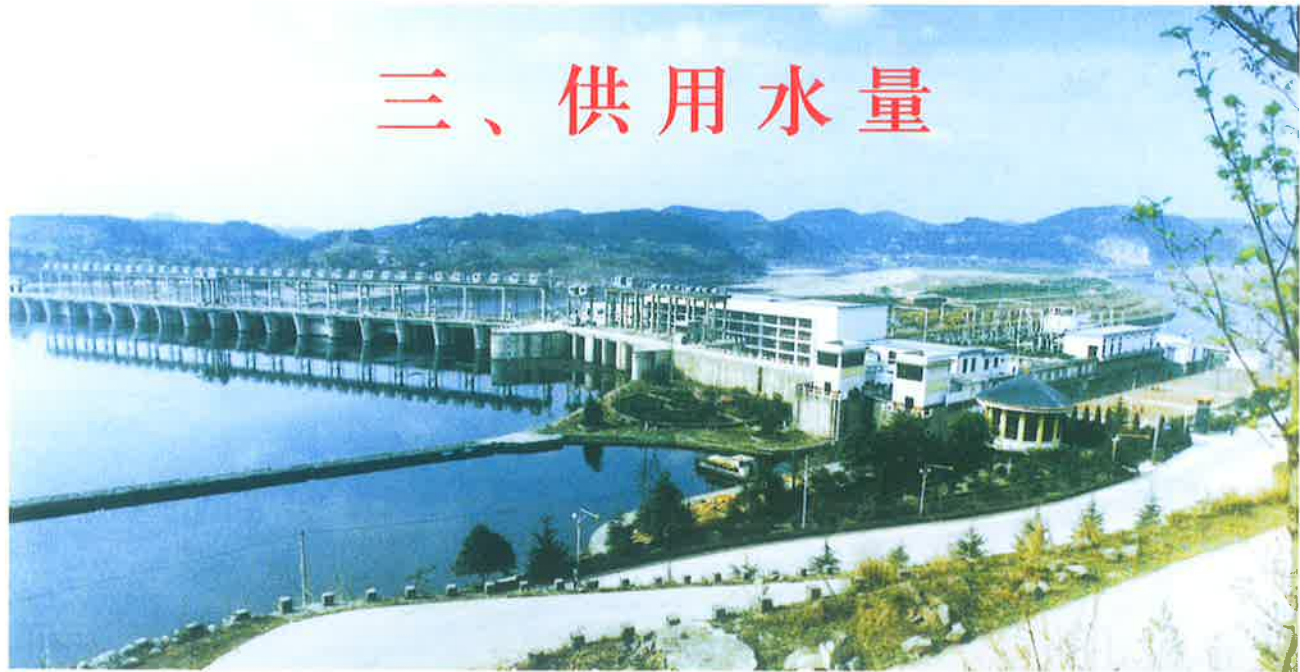
螺丝池水电站
