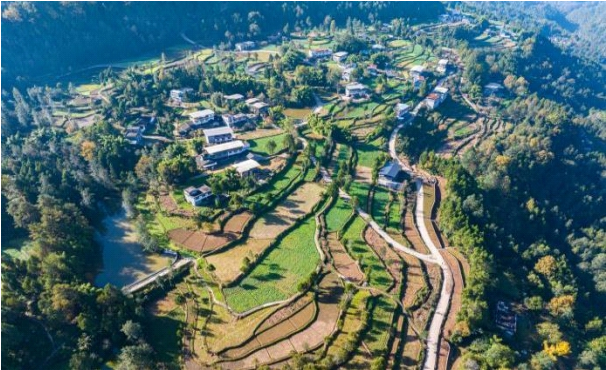
巴中市南江县双河小流域水土流失综合治理 提质增效项目
