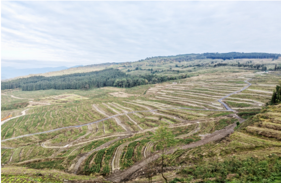
雅安市天全县铜厂河小流域水土流失综合治理 提质增效项目
