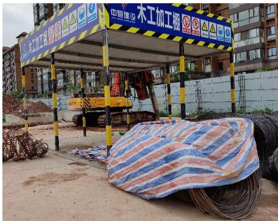
图 10 材料堆存防雨布遮盖措施图
