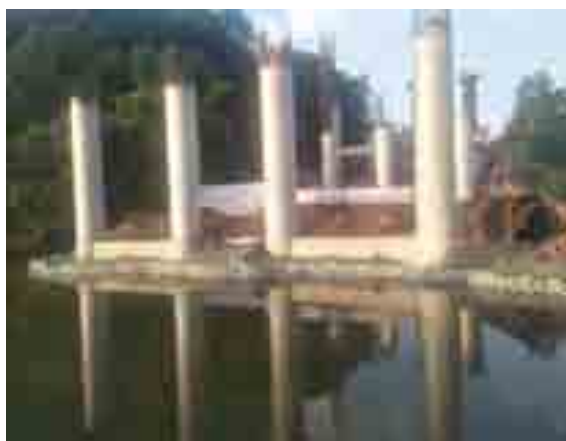
K16+495 观音山大桥施工现状
