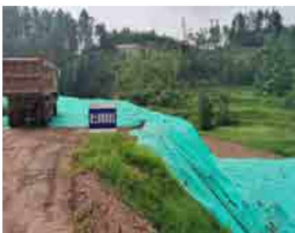
K26+780 弃渣场现状照片
