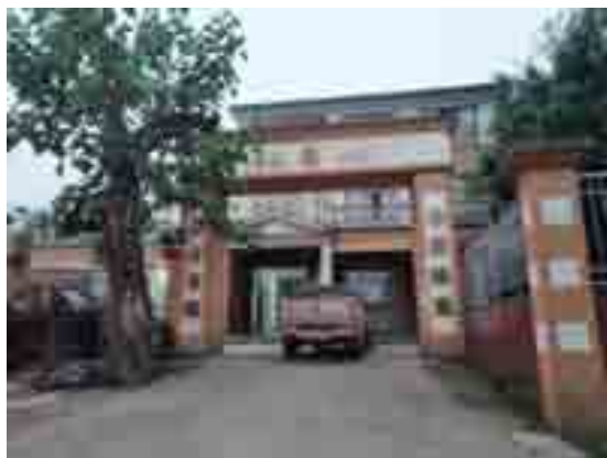
TJ1 施工班组驻地照片
