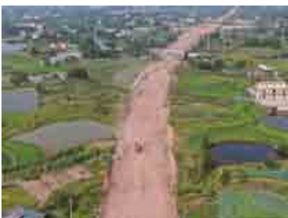
K9+200 路基现状照片
