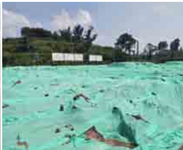
K24+800 弃渣场现状照片
