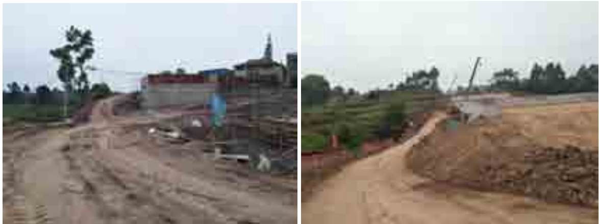
图 2.2-19 K28+643.5 梨子村中桥施工便道 图 2.2-20 K38+213 龙溪河中桥施工便道
