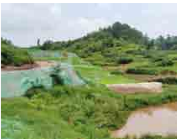
K34+700 弃渣场现状照片
