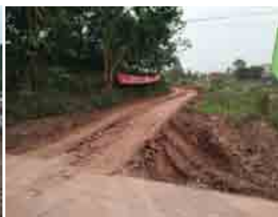
K24+800 路基施工进场便道
