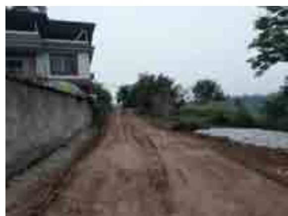
滩子口大桥施工便道
