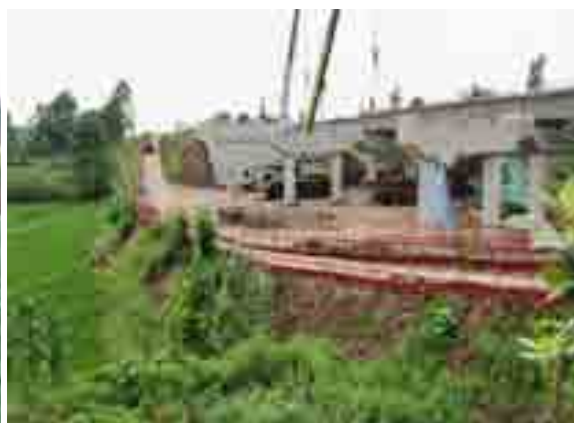
K38+902 道士弯中桥施工现状
