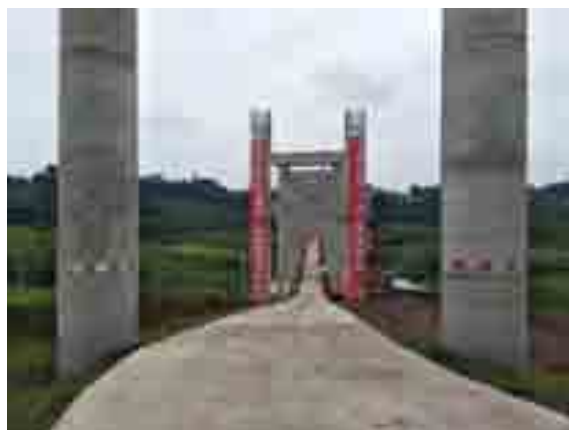
K0+860 濑溪河大桥施工现状
