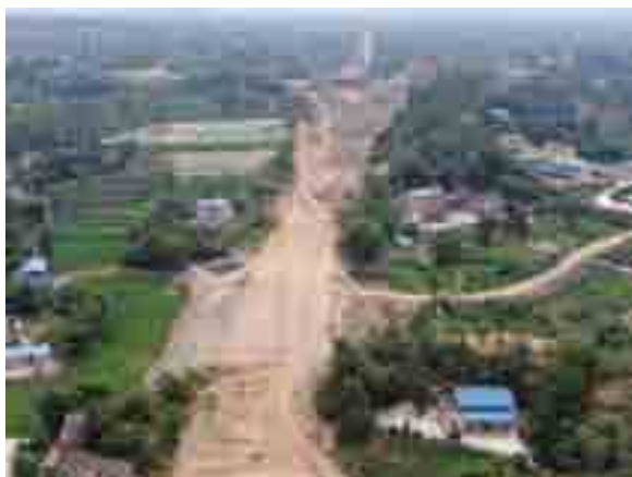
K36+000 路基现状照片
