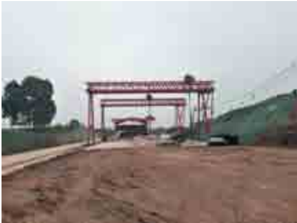
TJ4 预制场照片 表 2.1-24 施工场地区已实施水土保持措施统计表
