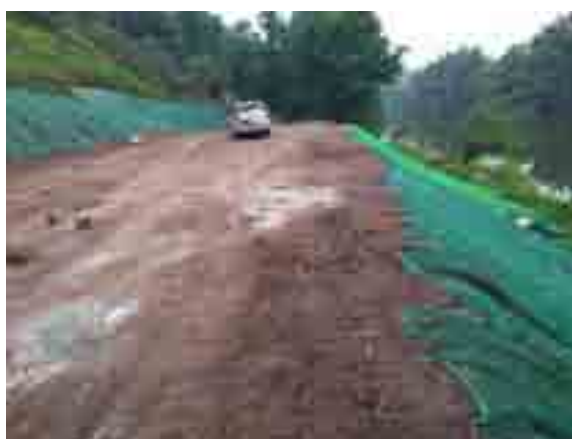
濑溪河大桥施工便道
