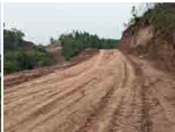
K26+780 弃渣场施工便道
