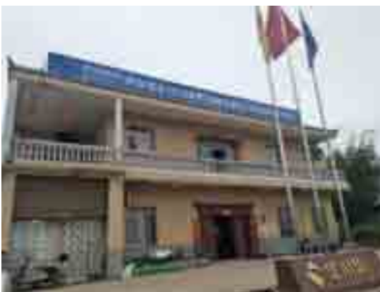
TJ4 施工班组驻地照片
