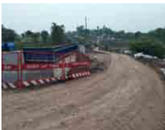
K24+075 楼子山大桥施工便道
