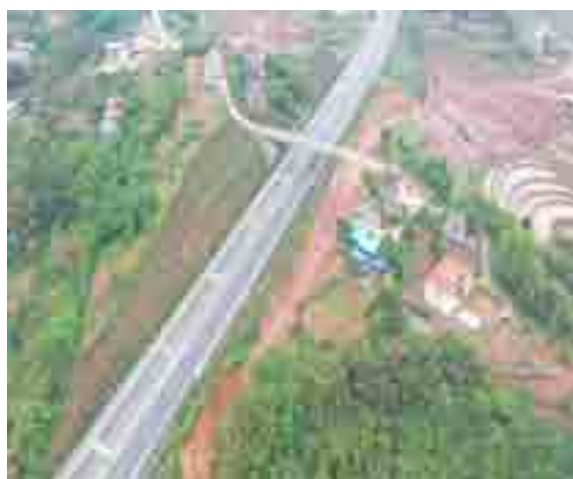
中和互通 E 匝道施工便道
