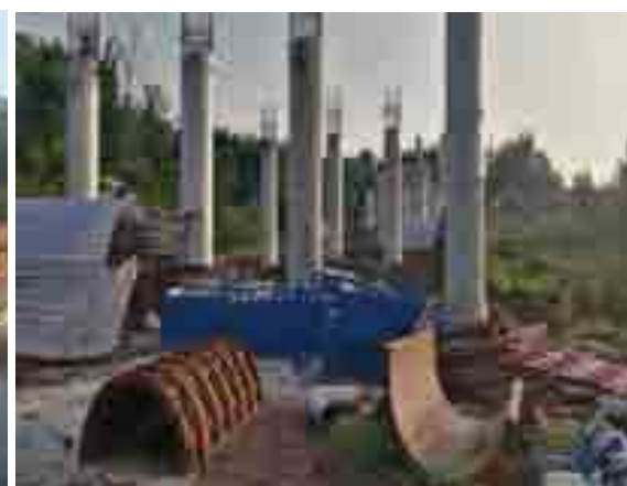
K16+495 观音山大桥施工现状
