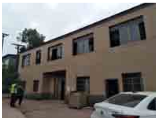
TJ3 施工班组驻地照片
