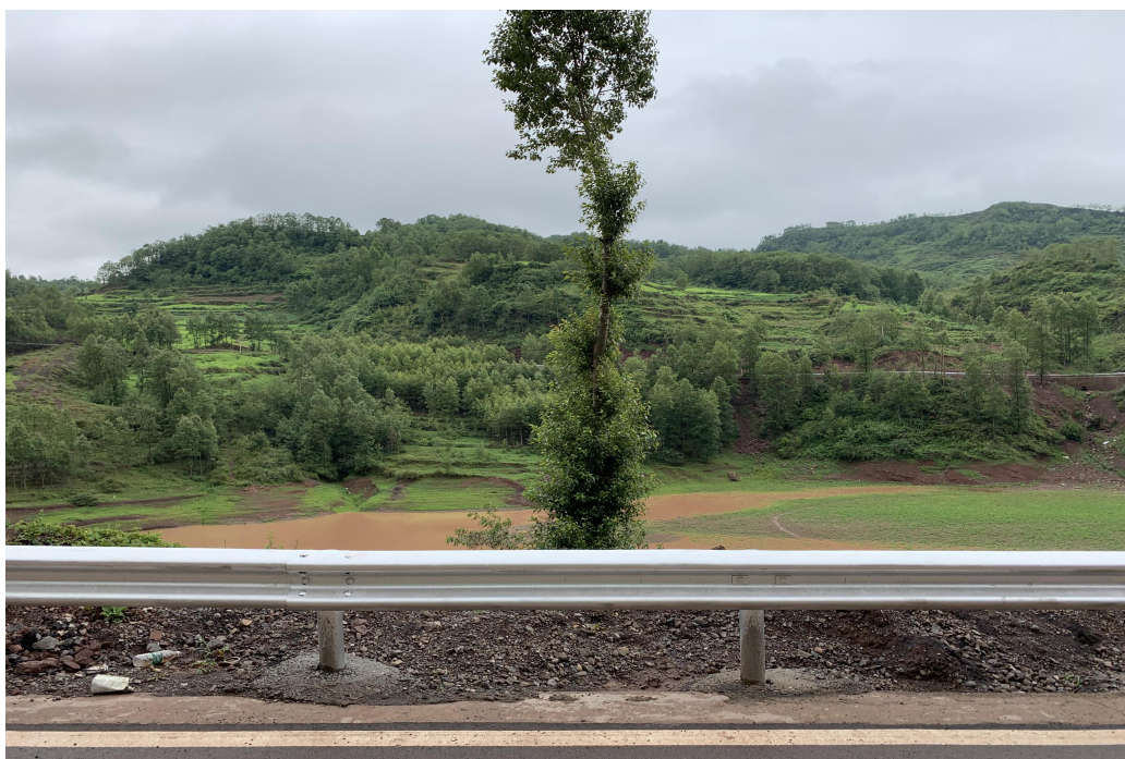
图 2-5 跨越洛古水库段现场图
