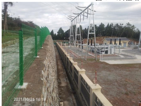
图2.1-24升压站北侧排水沟现状
