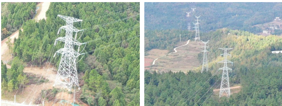
图2.1-28一期工程集电线路中架空线路建设情况（同类项目）
