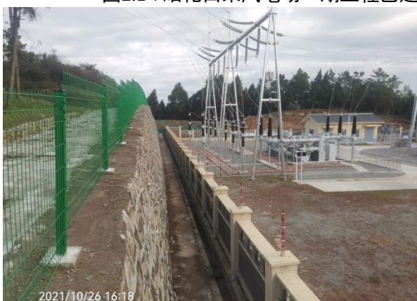
图2.1-8昭化白果风电场一期工程已建升压站（白果220kV升压站）站外排水沟
