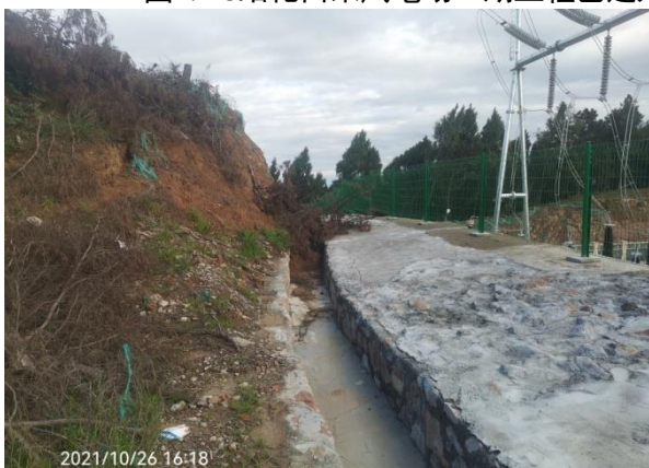
图2.1-9昭化白果风电场一期工程已建升压站（白果220kV升压站）站外截水沟
