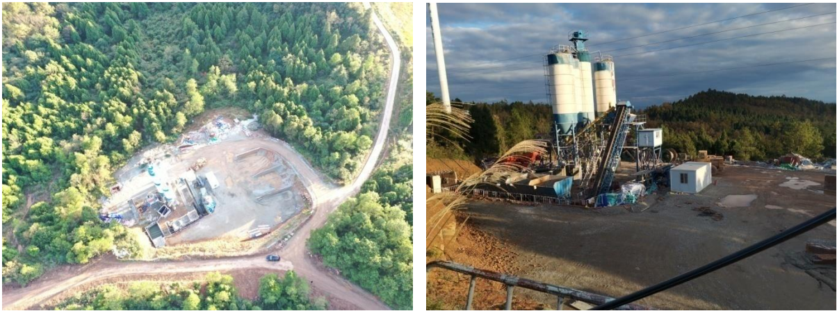
图2.2-1 一期工程施工临建现场布设情况（同类项目）
