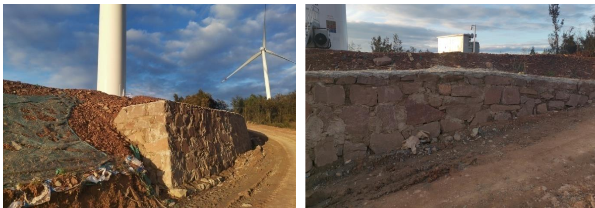
图2.1-33一期工程道路边坡浆砌石挡墙防护（同类项目）
