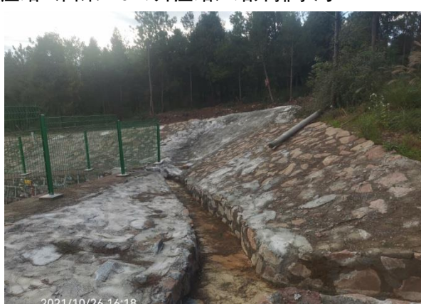
图2.1-9昭化白果风电场一期工程已建升压站（白果220kV升压站）站外截水沟
