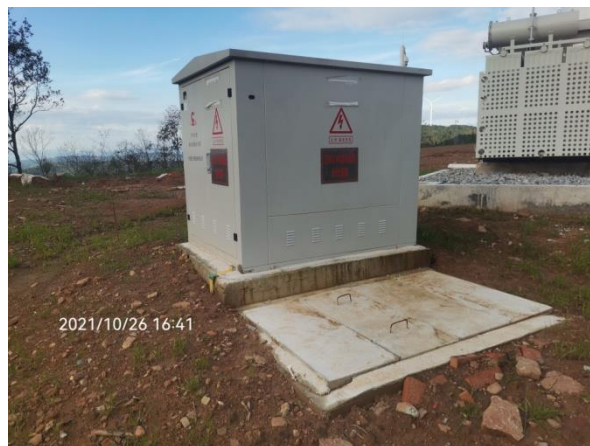
图 2.1-15 一期工程箱变基础成型图（同类项目）
