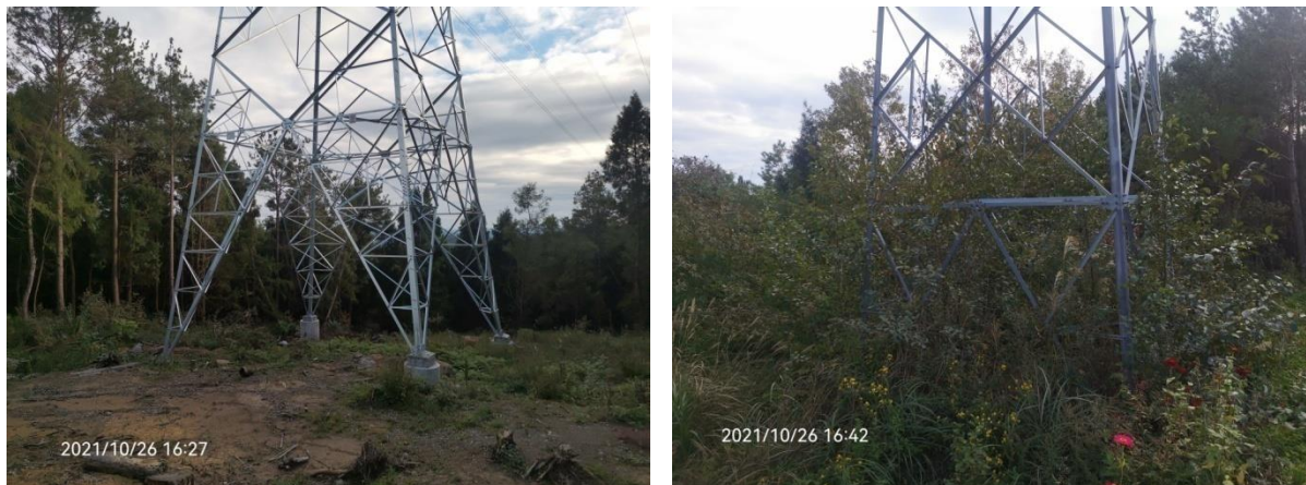
图2.1-29一期工程集电线路中架空线路建设情况（同类项目）
