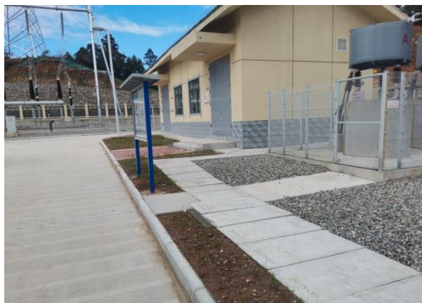
图2.1-7昭化白果风电场一期工程已建升压站（白果220kV升压站）碎石压盖
