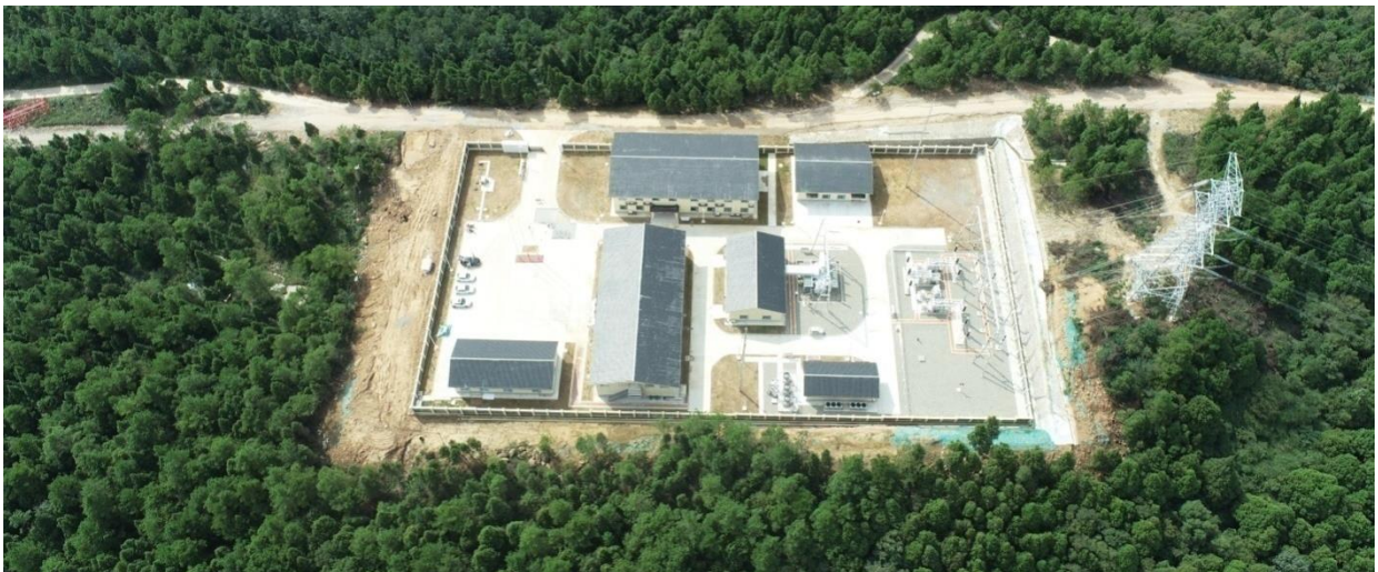
图 2.1-17 白果 220kV 升压站现状
