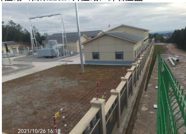
图2.1-8昭化白果风电场一期工程已建升压站（白果220kV升压站）站外排水沟
