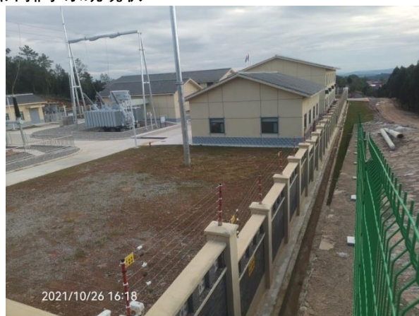
图2.1-25升压站西侧排水沟现状
