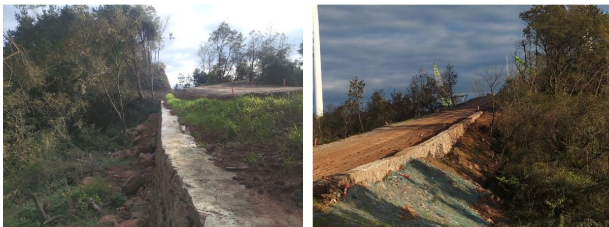
图2.1-34一期工程道路边坡浆砌石挡墙防护（同类项目）
