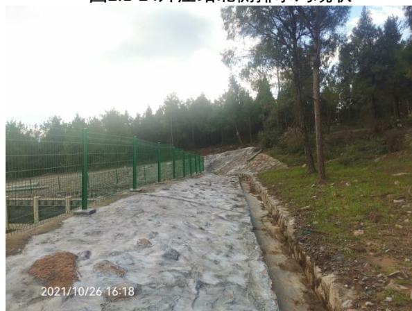
图2.1-26升压站西北侧截水沟现状
