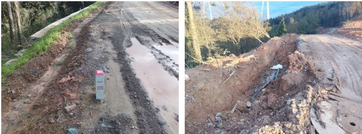
图2.1-27 一期工程地埋电缆敷设情况（同类项目）
