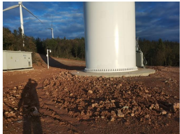
图 2.1-13 一期工程风机基础成型图（同类项目）
