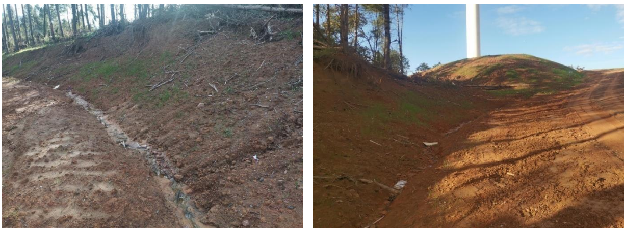
图 2.1-37 一期工程道路土质排水沟（同类项目）
