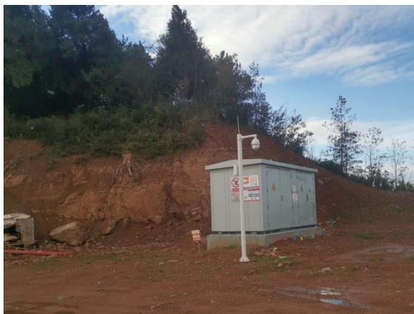
图 2.1-15 一期工程箱变基础成型图（同类项目）
