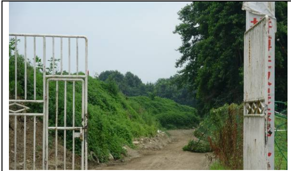
彭州5临时堆土场临时种草及拦挡
