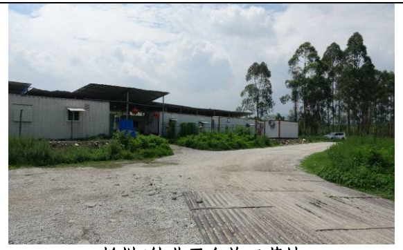
彭州4钻井平台施工营地
