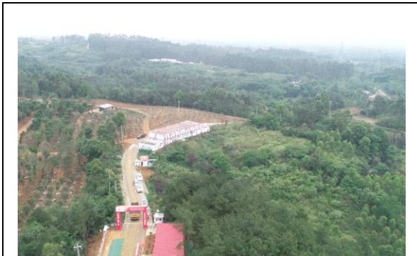
彭州3钻井平台施工营地
