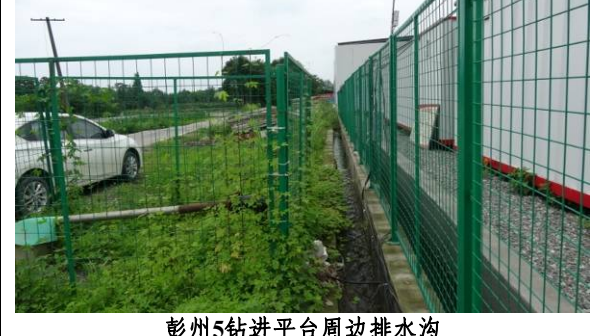
彭州5钻井平台周边排水沟
