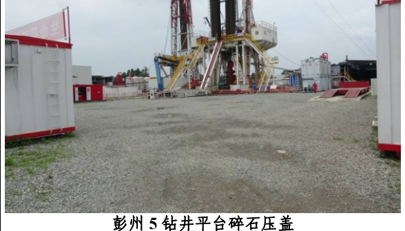
彭州5钻井平台碎石压盖
