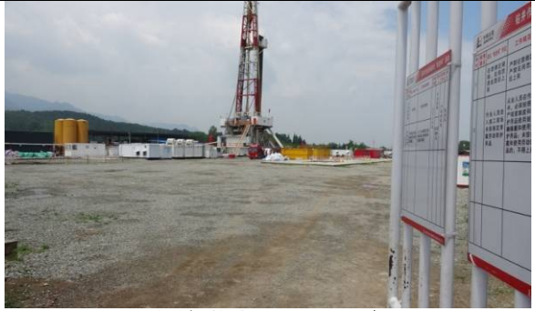
彭州8钻井平台碎石压盖
