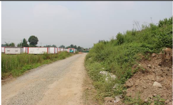
彭州6临时堆土场（二）
