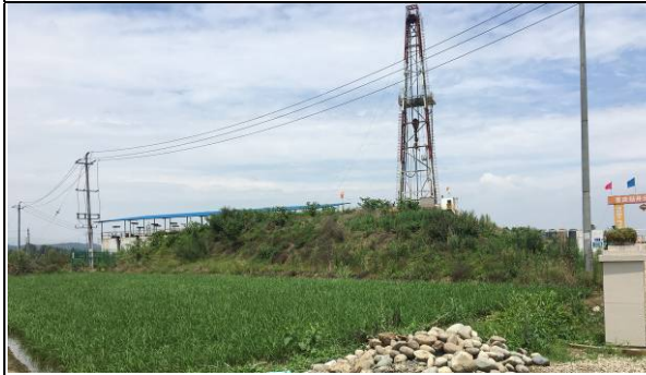
彭州7临时堆土场（一）
