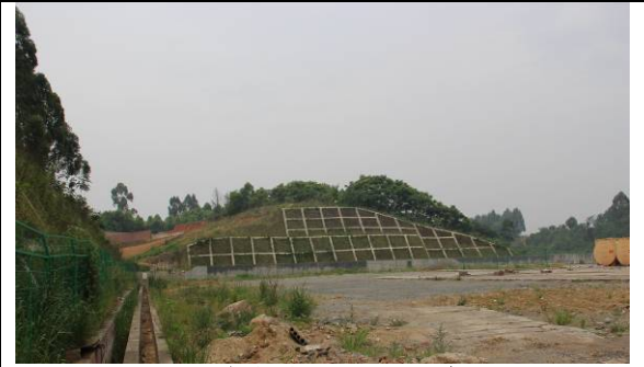
彭州3钻井平台碎石压盖
