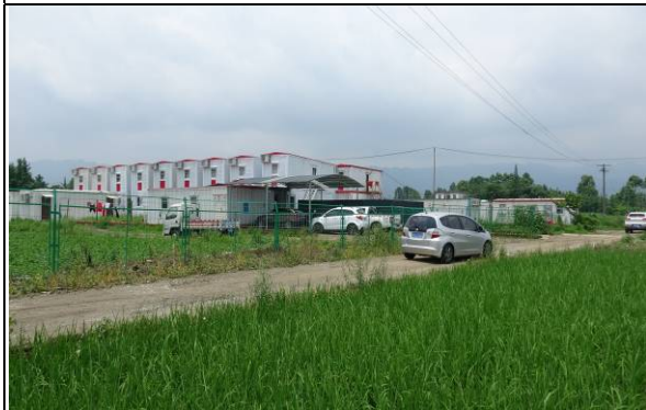
彭州5钻井平台场施工营地
