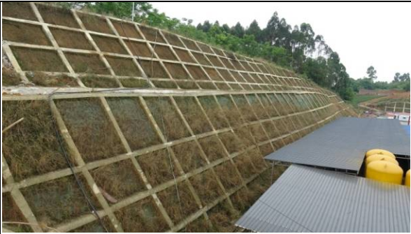
彭州3钻井平台框格植草护坡（二）
