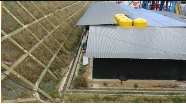
彭州3钻井平台坡脚排水沟
