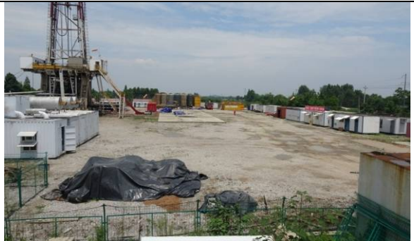
彭州7钻井平台碎石压盖
