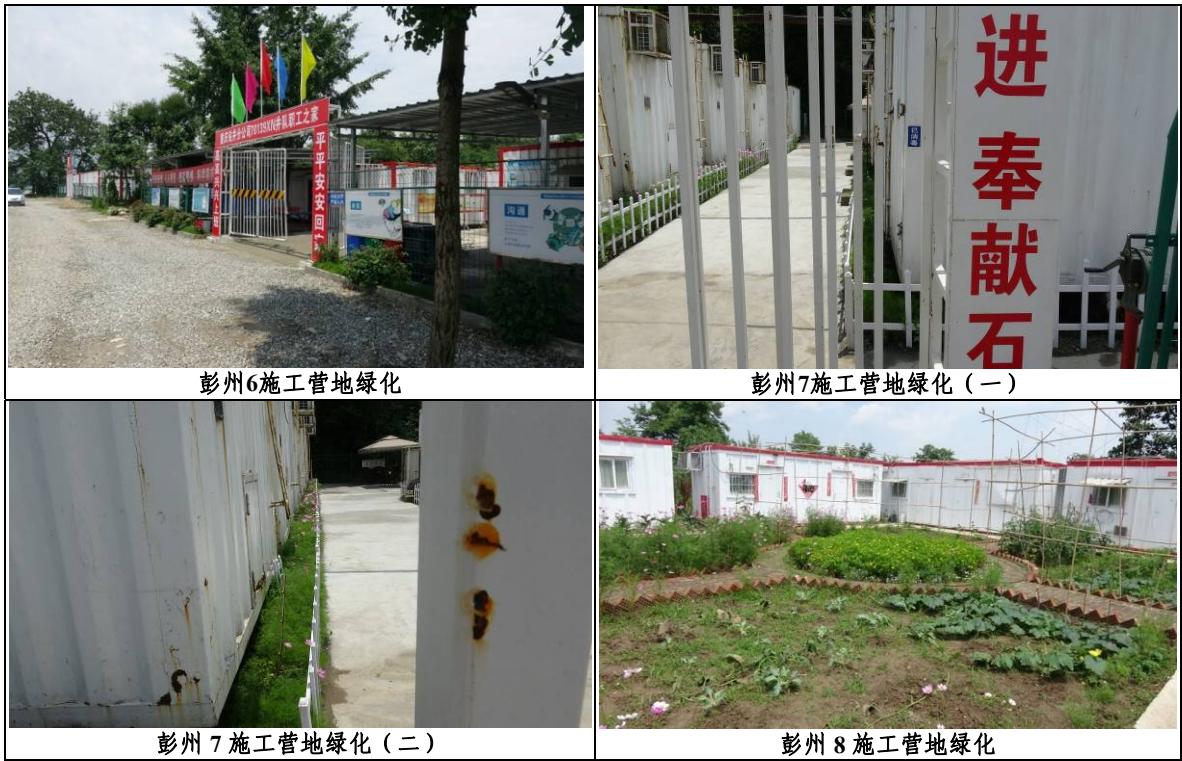
钻井平台施工营地临时绿化
