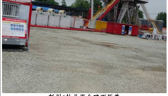
彭州6钻井平台碎石压盖
