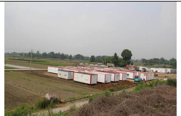
彭州6钻井平台1#施工营地
