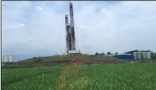
彭州6临时堆土场（一）
