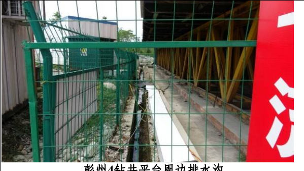
彭州4钻井平台周边排水沟
