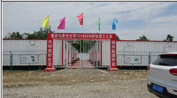
彭州6钻井平台2#施工营地
