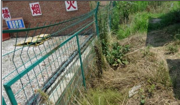
彭州7钻井平台周边排水沟
