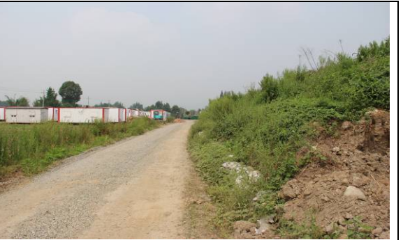
彭州6临时堆土场临时种草及拦挡
