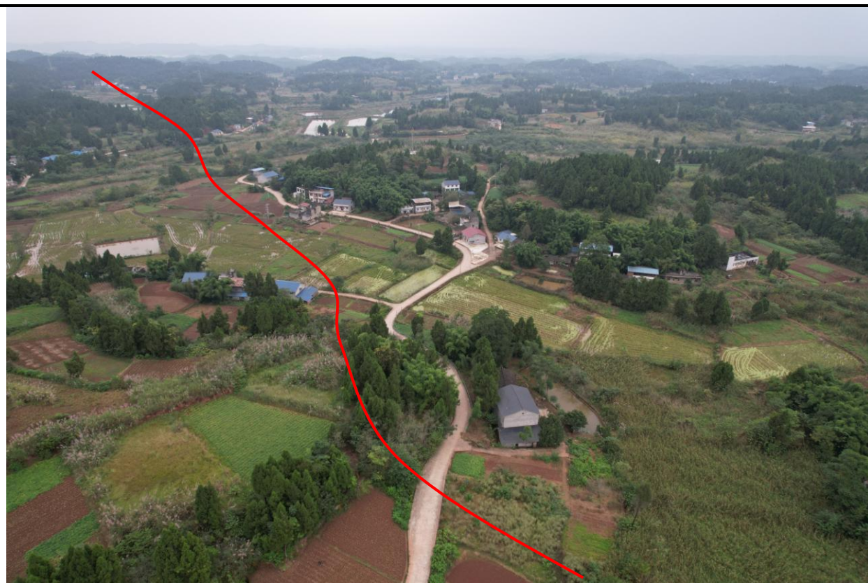
供气管线小杨家湾末站附近沿线情况
