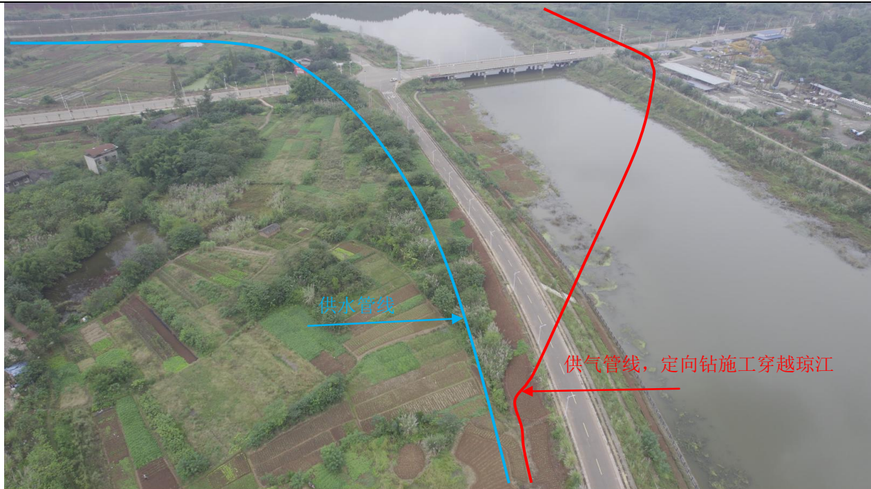
电厂厂址西南方向供水、供气管线沿线情况
