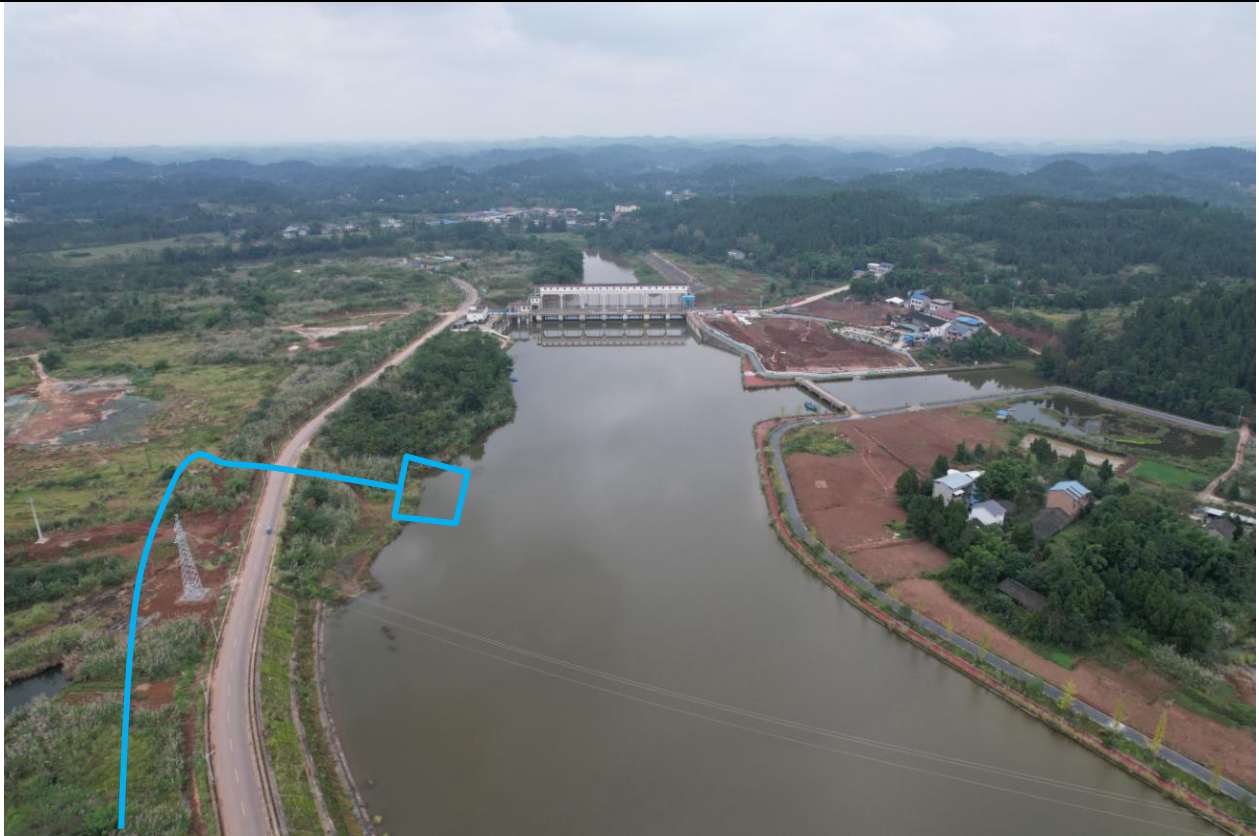
取水口、供水管线沿线情况
