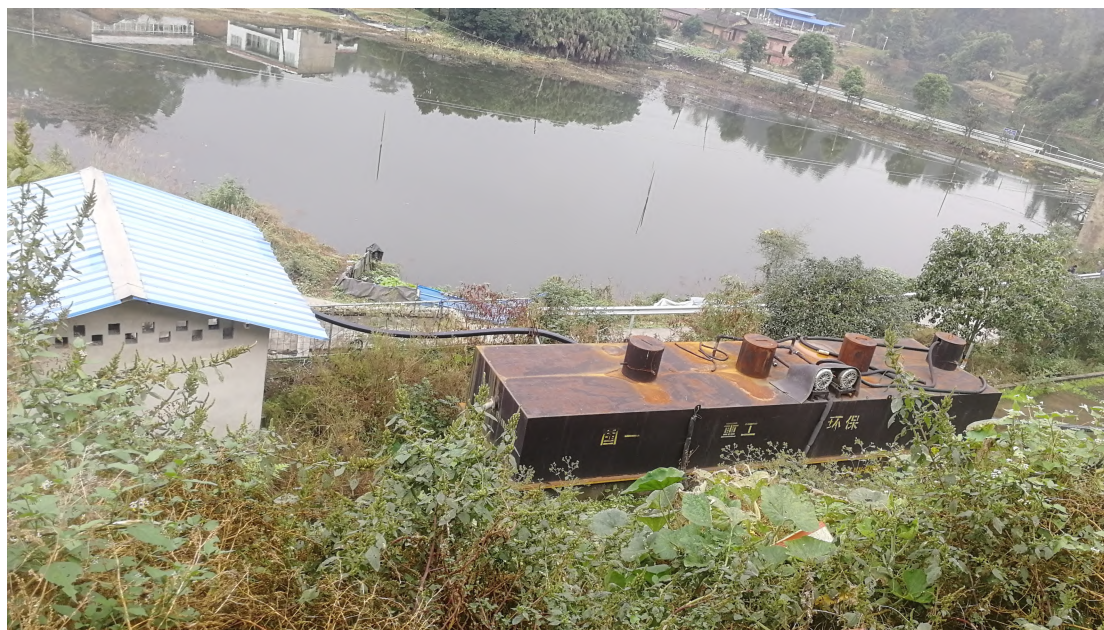
副斜井工业场地污水处理系统及周边道路
