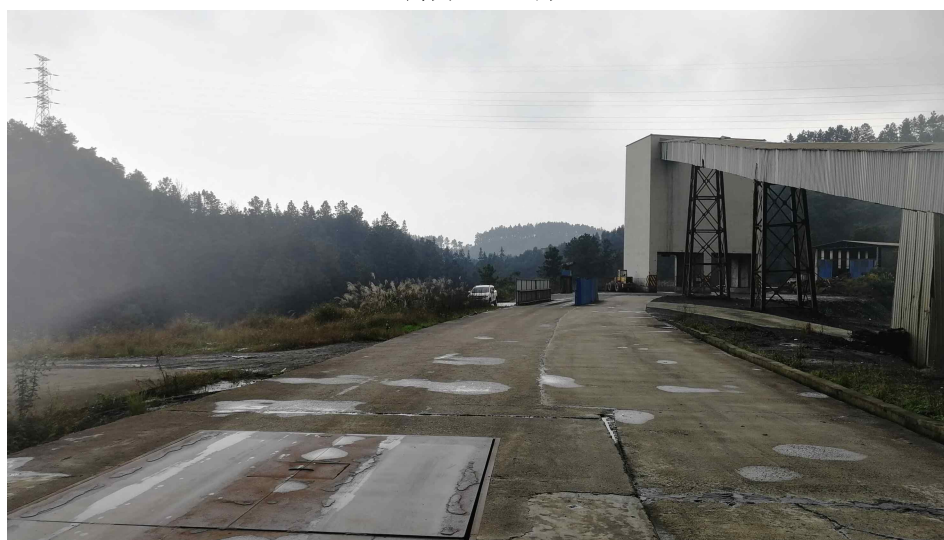
主斜井工业场地道路
