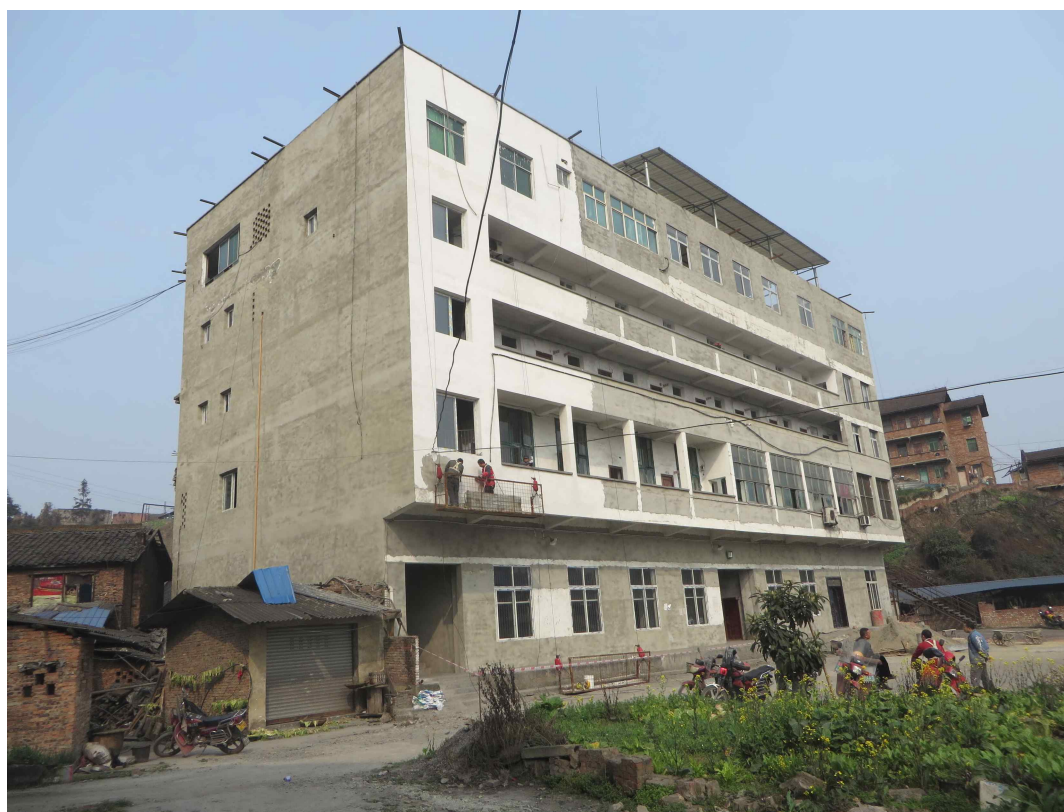
副斜井工业场地
