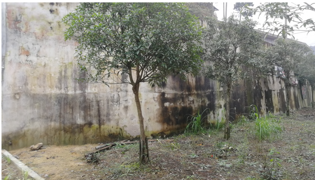
副斜井工业场地护坡
