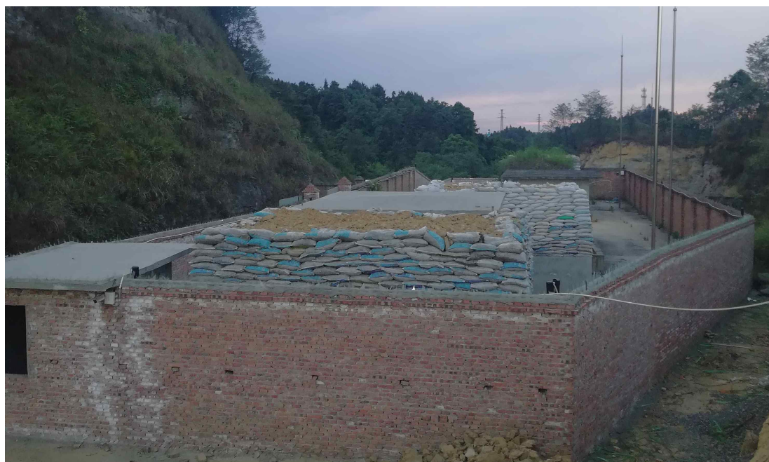
图 3.2-7 炸药库场地现状
