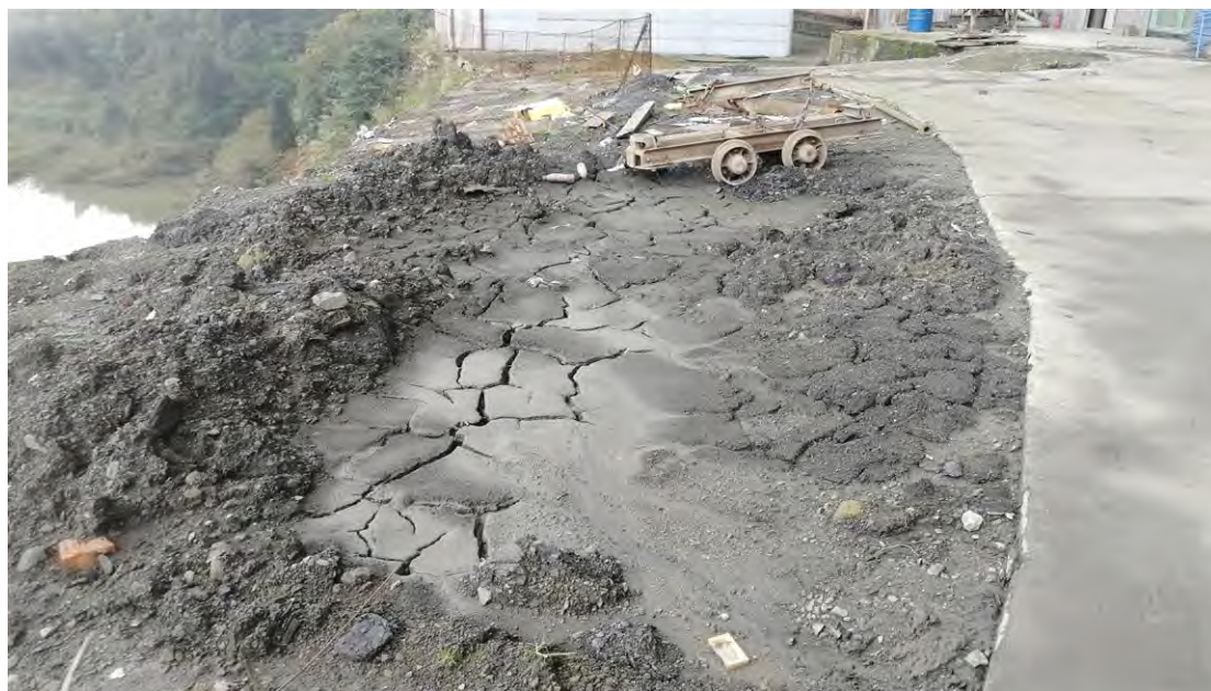
主斜井工业场地施工扰动区域
