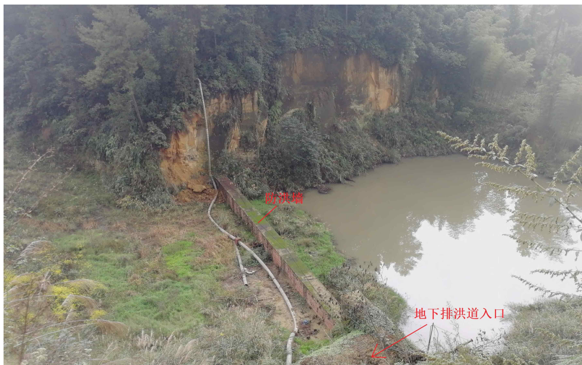
图 3.2-4 排洪道及防洪墙现状
