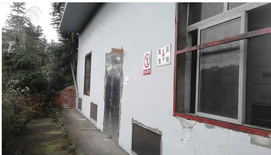
风井场地设施
