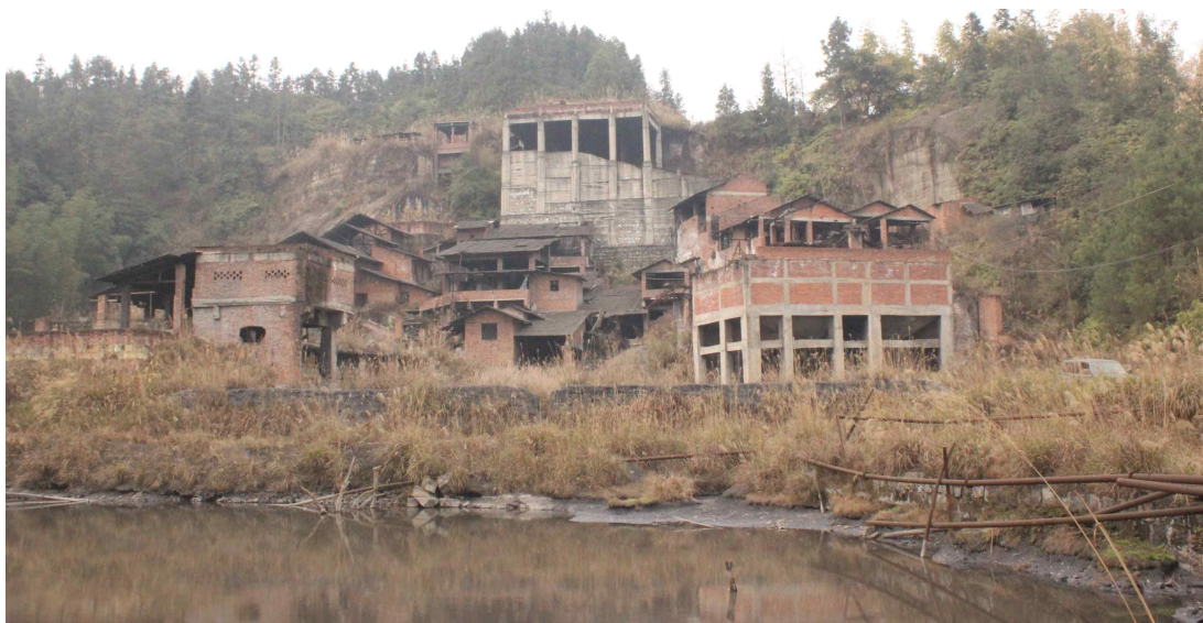
原精煤加工场地土地损毁现状（目前已经拆除）
