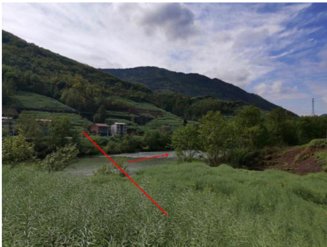
穿越点现场照片
