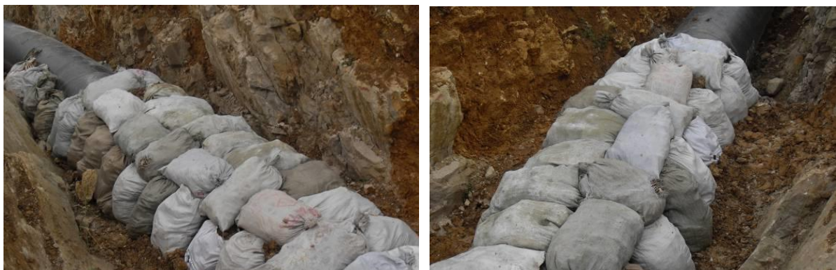
石方段管沟编织袋管道保护现场参考照片
