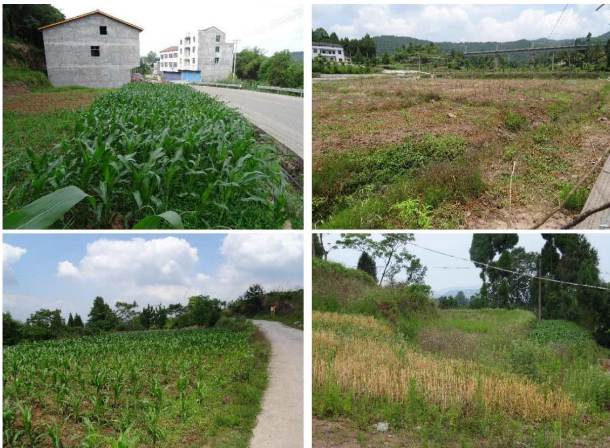
管道作业带复耕及恢复林地措施
