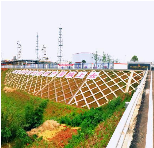
站场边坡防护
