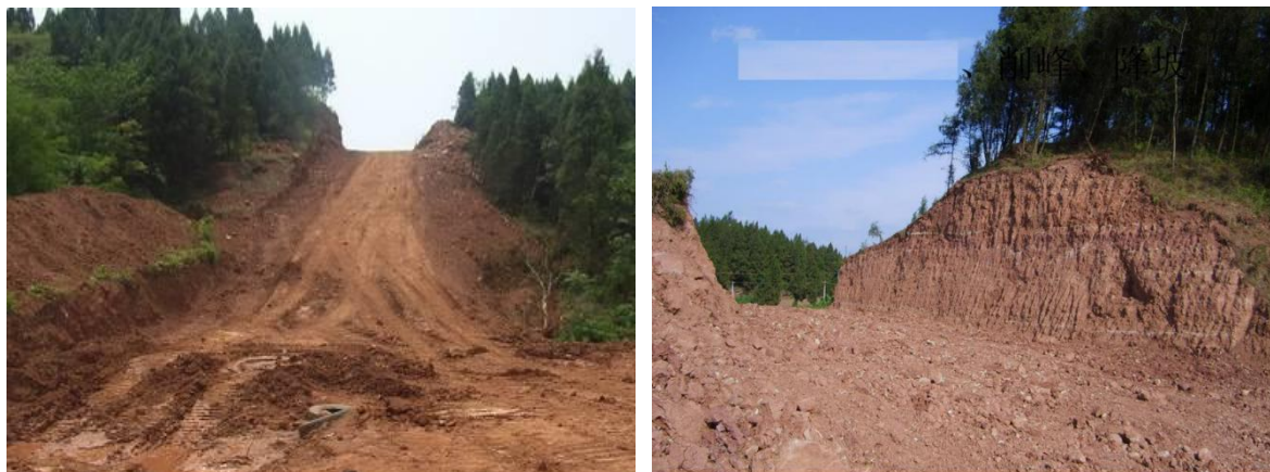
削峰降坡现场参考照片
