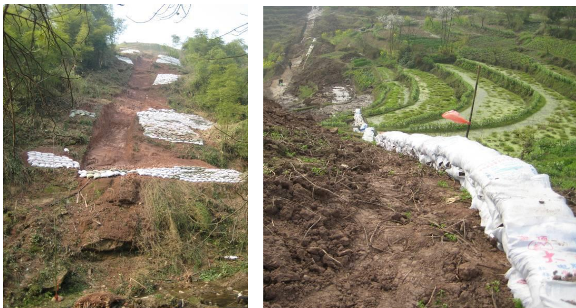
编织袋挡土墙砌筑现场参考照片
