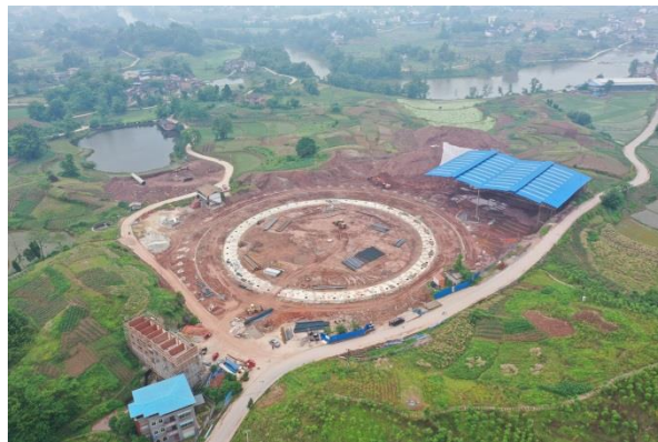
图 3.2-2 正在改扩建的邻水县复盛乡平安页岩砖厂（里程约 5km）
