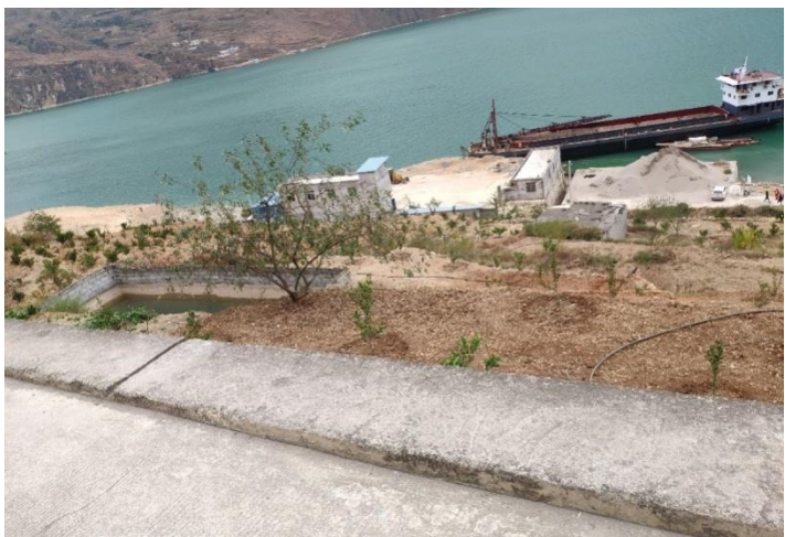
千万贯车渡码头现状
