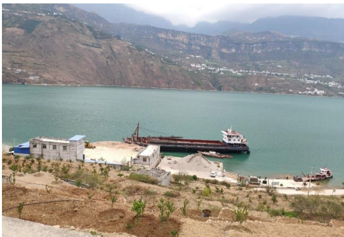
千万贯车渡码头现状
