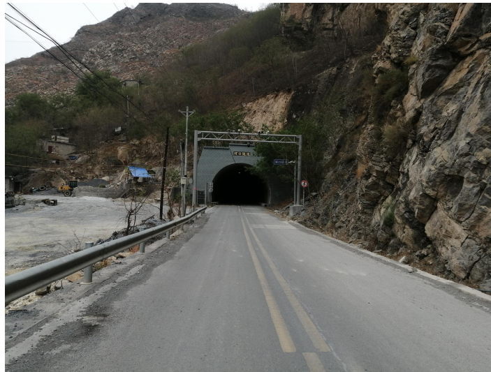
河口隧道进口
