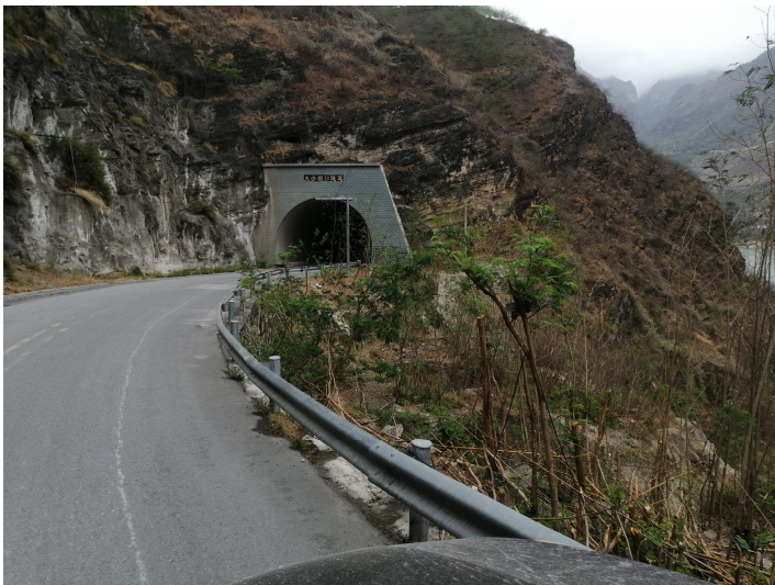
大坝沙 3#隧道出口
