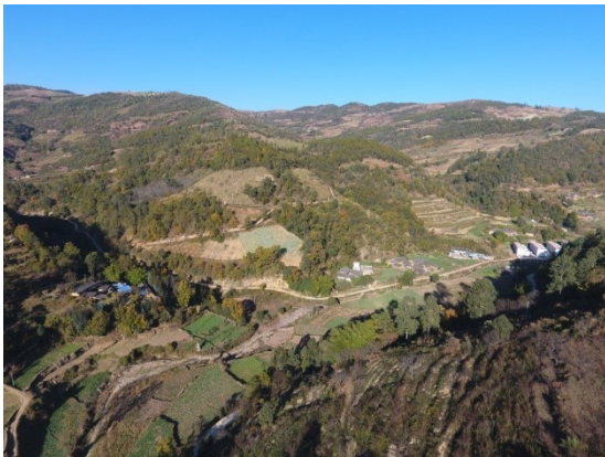
熊普2号大桥起点位置 (AK11+000)
