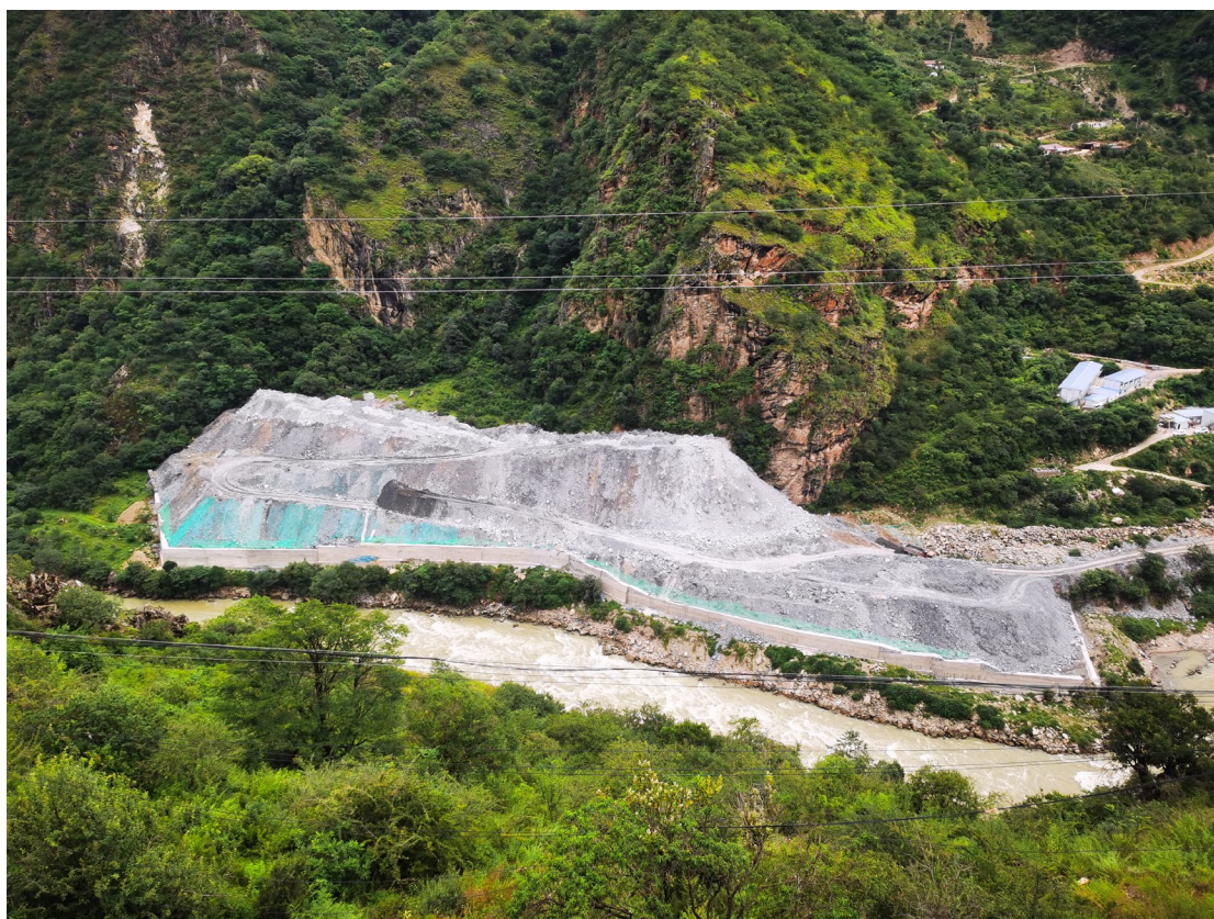
图 1.2-3 5-1#渣场建成后的现状实景图
