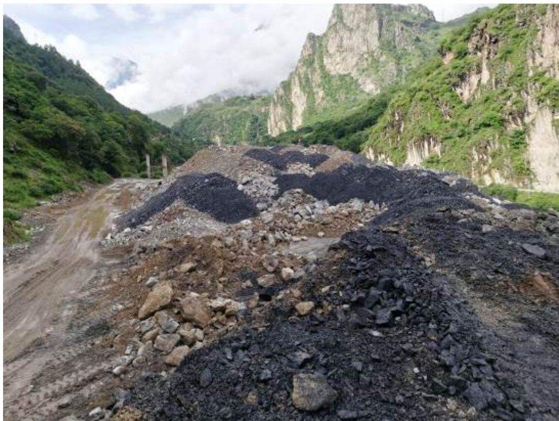
图 2-9 3#渣场形象面貌
