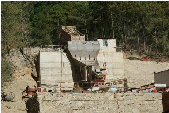
图 2-5 4#支洞料场面貌 3
