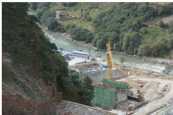
图 1-9 厂房施工区面貌 1
