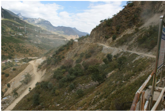
图 1-19 调压井施工道路面貌
