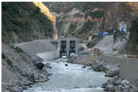
图 1-1 大坝施工面貌 1
