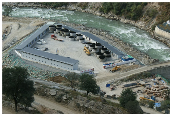
图 1-10 厂房施工区面貌 2
