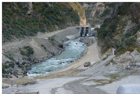
图 1-2 大坝施工面貌 2
