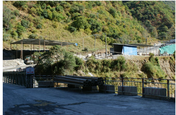
图 1-14 2#施工道路面貌
