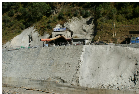
图 1-4 2#施工支洞面貌
