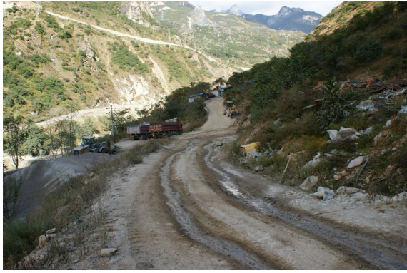
图 1-17 5#施工道路面貌 1
