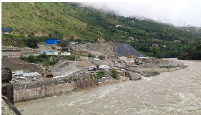
图 2-13 6#渣场I区、II区形象面貌
