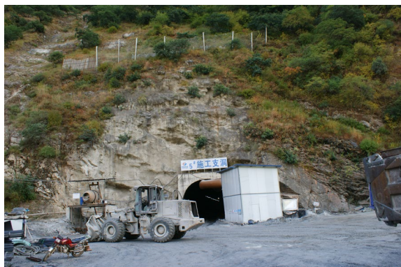
图 1-7 5#施工支洞面貌
