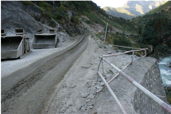
图 1-13 1#施工道路面貌
