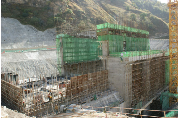
图 1-11 地面厂房面貌 1
