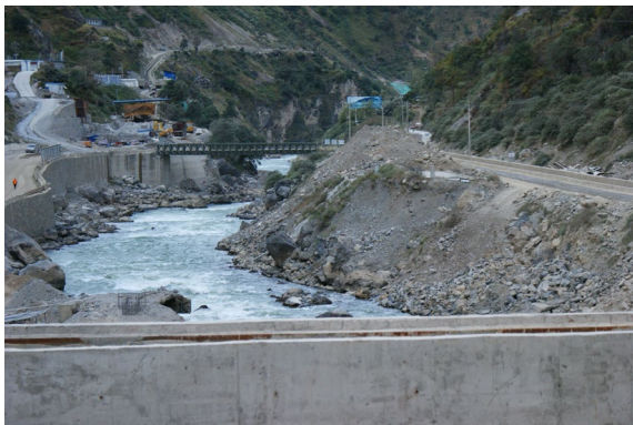
图 1-21 大坝贝雷桥面貌
