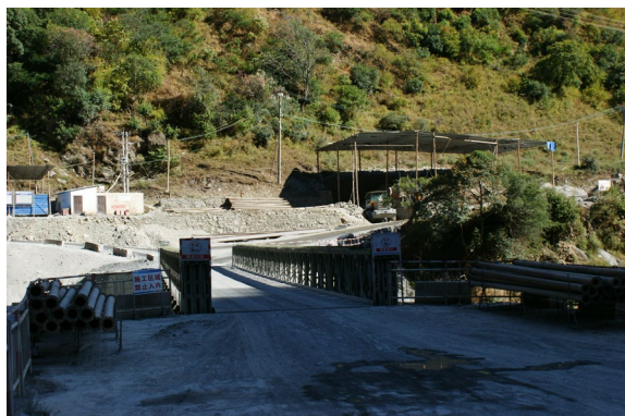
图 1-23 2#施工支洞贝雷桥面貌
