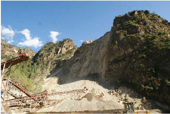
图 2-3 4#支洞料场面貌 1
