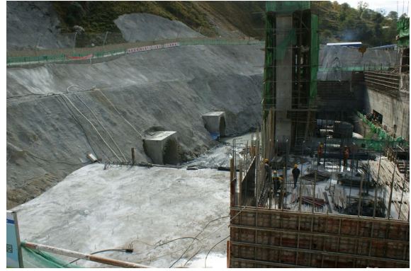
图 1-12 地面厂房面貌 2
