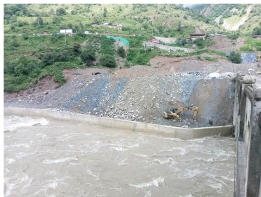
图 2-14 6#渣场III区形象面貌
