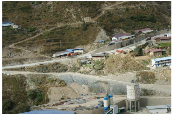
图 1-20 进厂施工道路面貌
