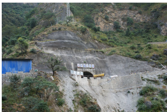
图 1-3 1#施工支洞面貌
