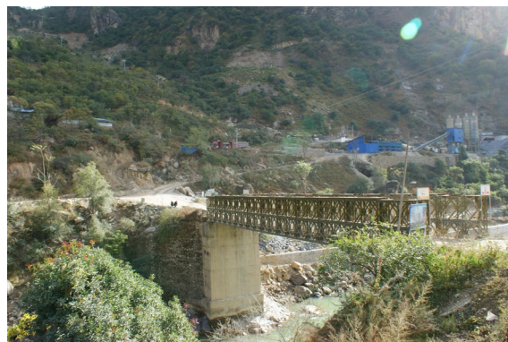
图 1-24 5#施工支洞贝雷桥面貌
