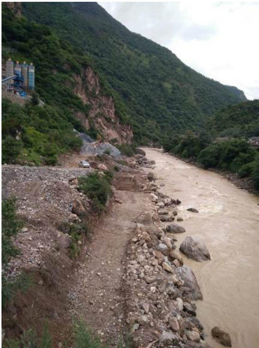
图 2-11 5#渣场形象面貌
