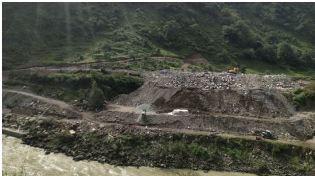
图 2-7 1#渣场形象面貌
