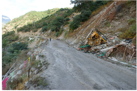
图 1-18 5#施工道路面貌 2
