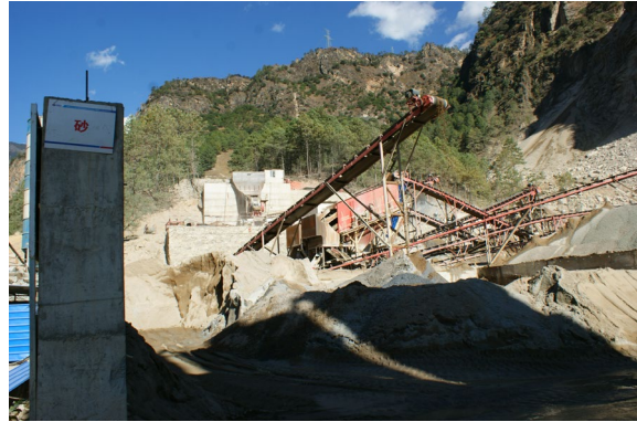
图 2-4 4#支洞料场面貌 2
