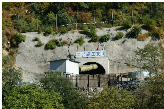
图 1-5 3#施工支洞面貌
