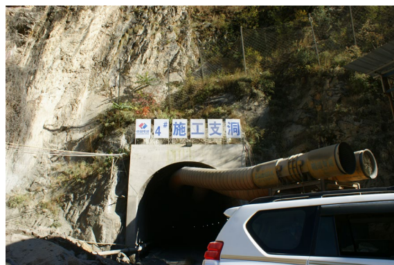
图 1-6 4#施工支洞面貌
