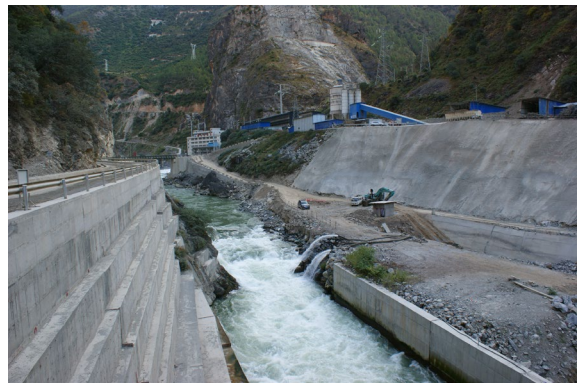
图 1-22 1#施工支洞贝雷桥面貌
