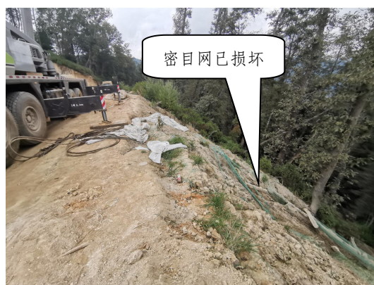
已损坏的风机平台密目网
