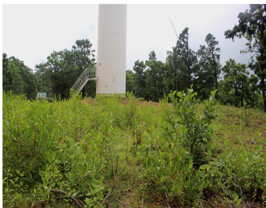
已绿化的风机平台
