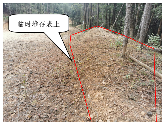
风机吊装平台临时堆存的表土
