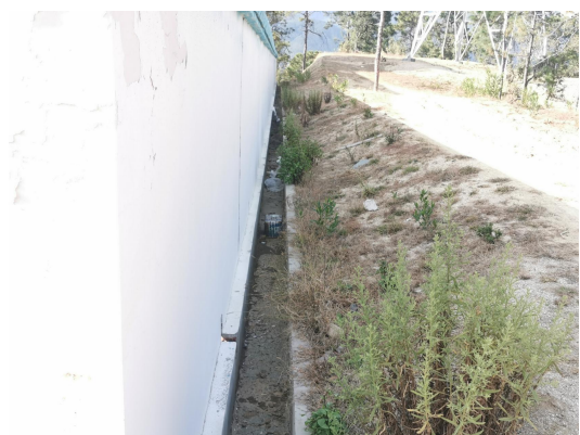
已实施的升压站排水沟
