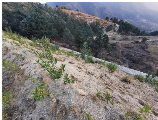
4#弃渣场坡面绿化
