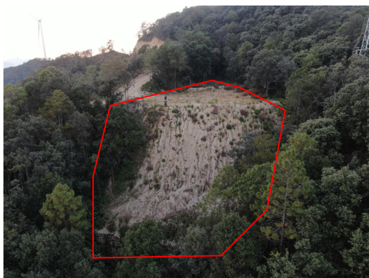
5#弃渣场全景照片
