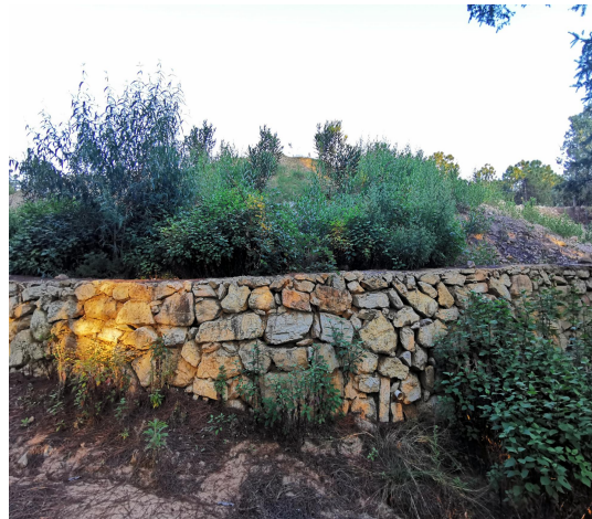
已实施浆砌石挡墙
