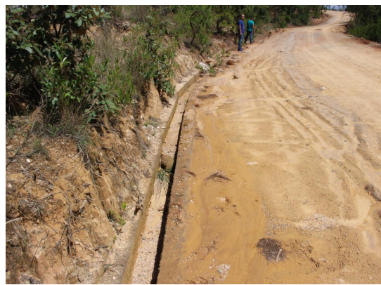
干坝子道路工程边沟现状
