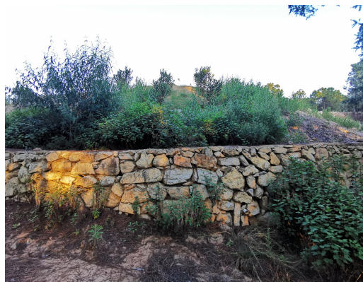
已实施的弃渣场挡墙
