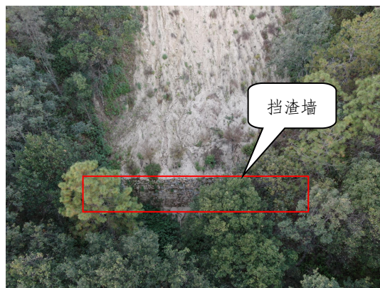
已实施浆砌石挡墙
