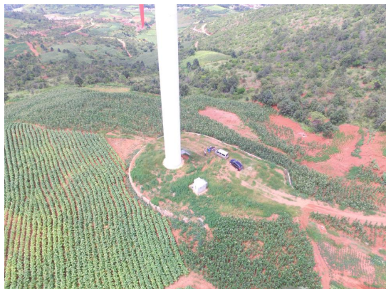
干坝子风机绿化现状
