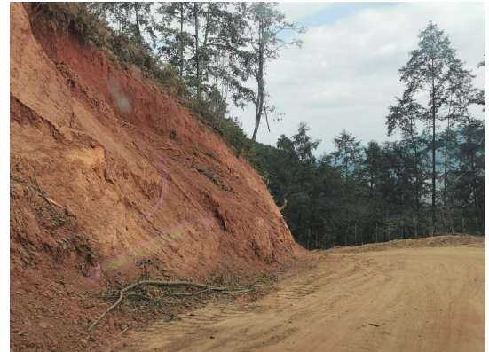
道路裸露边坡
