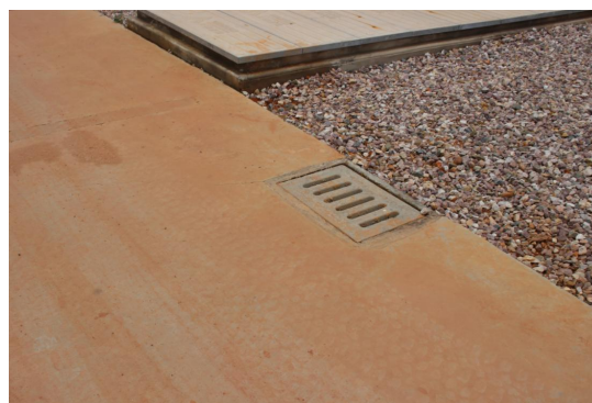
干坝子升压站内雨水口现状
