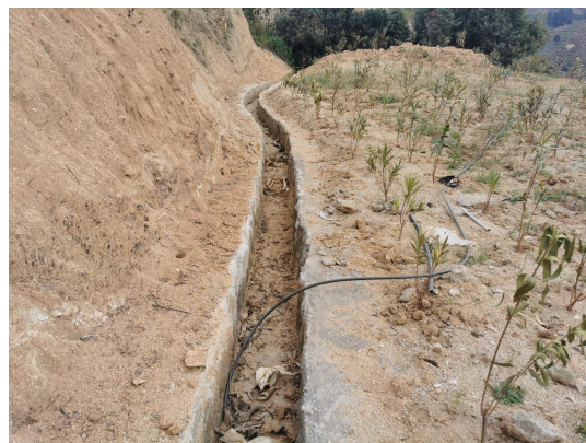
已实施的截排水沟
