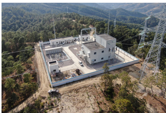
已建成的升压站
