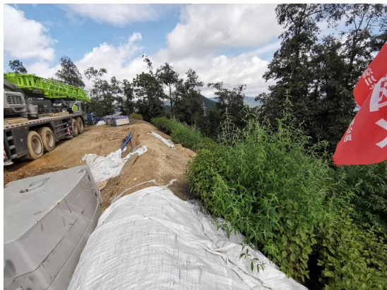
风机吊装平台工程密目网临时遮盖
