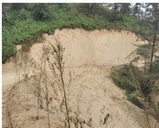
已实施的道路边坡绿化措施
