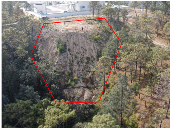
1#弃渣场全景照片
