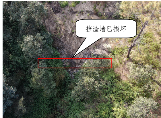
已损坏挡渣墙
