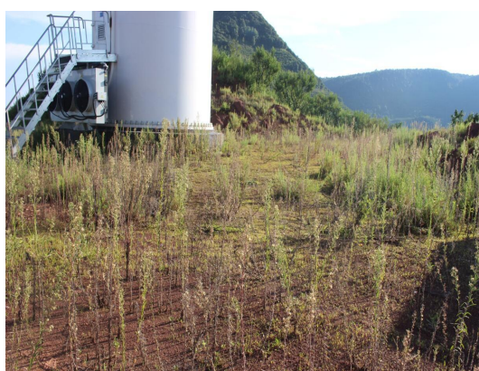
已绿化的风机平台
