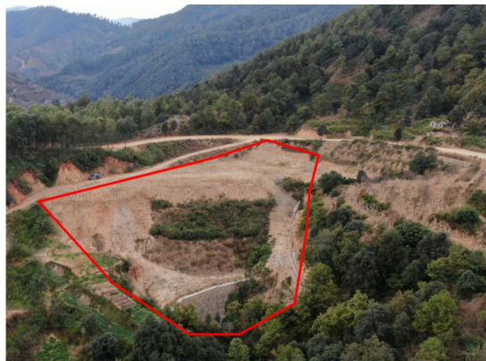
2#弃渣场全景照片
