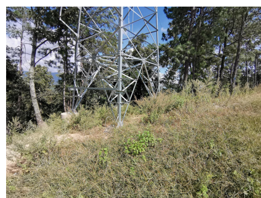
已实施的塔基绿化
