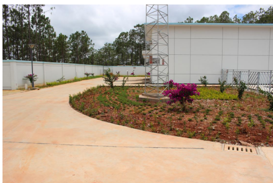
干坝子升压站硬化及景观绿化现状
