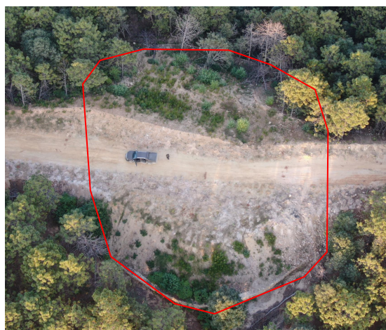
3#弃渣场全景照片
