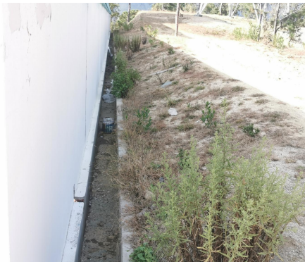
升压站围墙外砖砌排水沟
