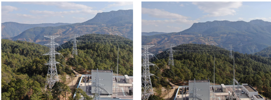
黄角垭风电场 220kV 送出工程现场照片
