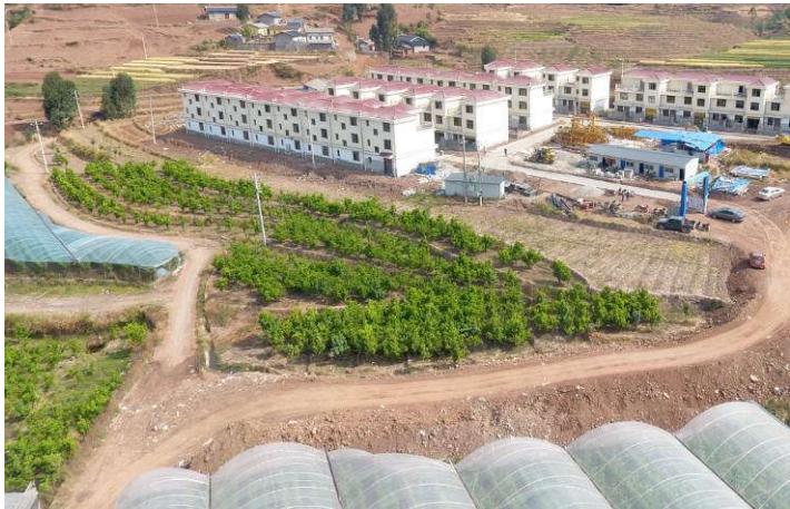
图 2.2-4 罗锅背居民点施工便道照片
