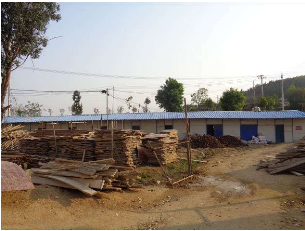
图 2.2-5 李家沟居民点施工场地照片
