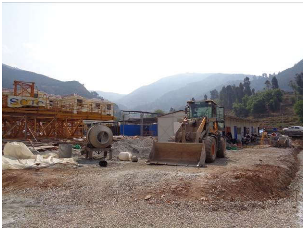
图 2.2-3 罗锅背居民点施工场地照片
