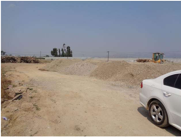
图 2.2-2 大庄居民点施工场地照片
