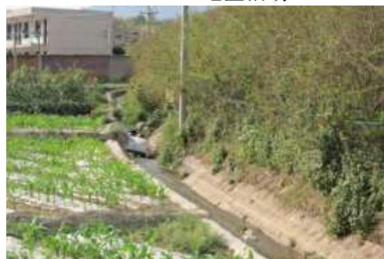
K42 填方边坡、排水沟
