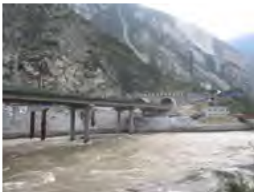
在建映汶路临河型弃渣场浸水挡墙
