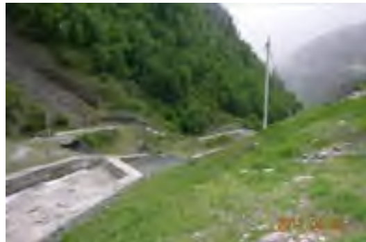
临沟型弃渣场：排水沟+挡渣墙+植草绿化
