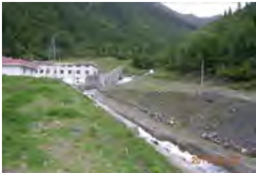
临沟型弃渣场：排水沟+挡渣墙+植草绿化
