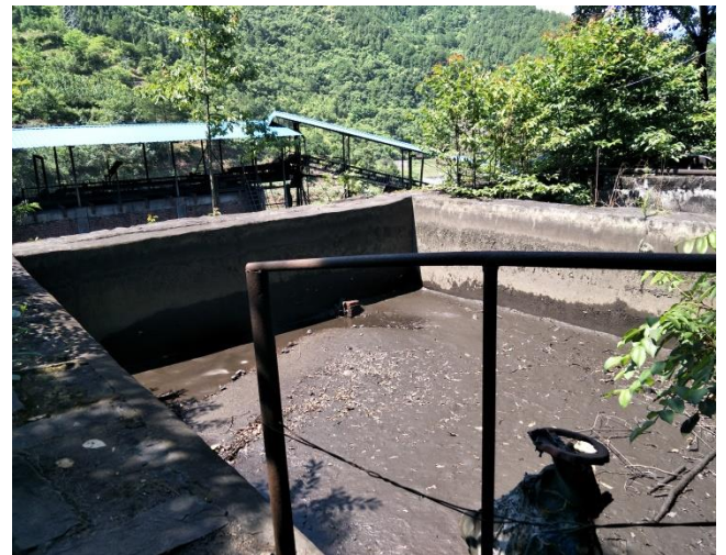
图 3.2-8 储煤场的沉池
