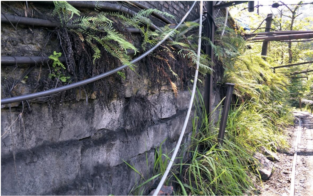
图 3.2-6 储煤场的挡土墙
