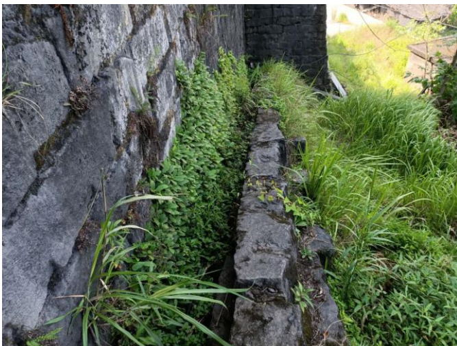
图 3.2-7 储煤场的排水沟
