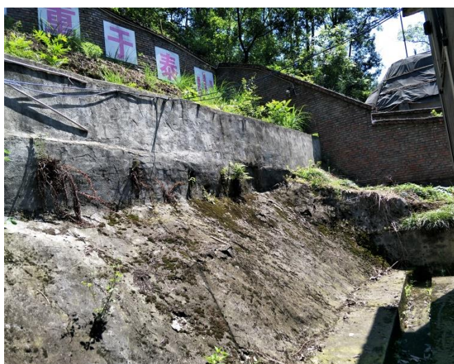
图 3.2-10 炸药库的挡土墙
