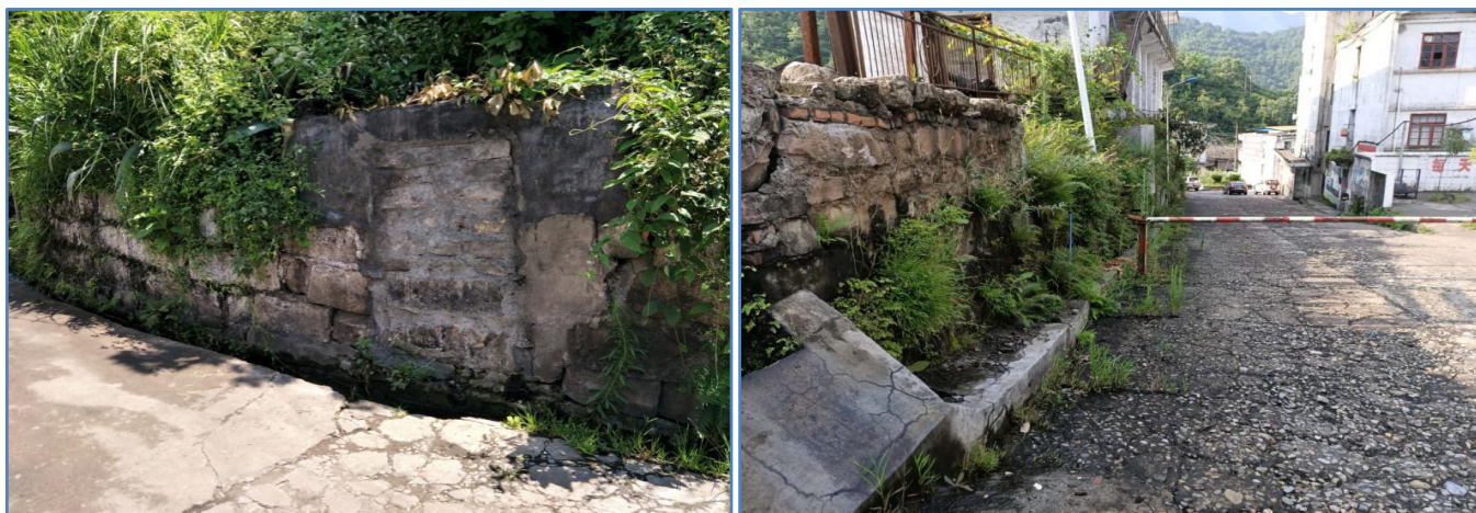
图 3.2-2 生产生活区挡土墙
