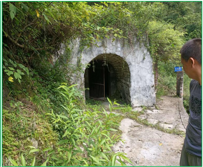
图 2.1-6 +637m 东翼回风平硐
