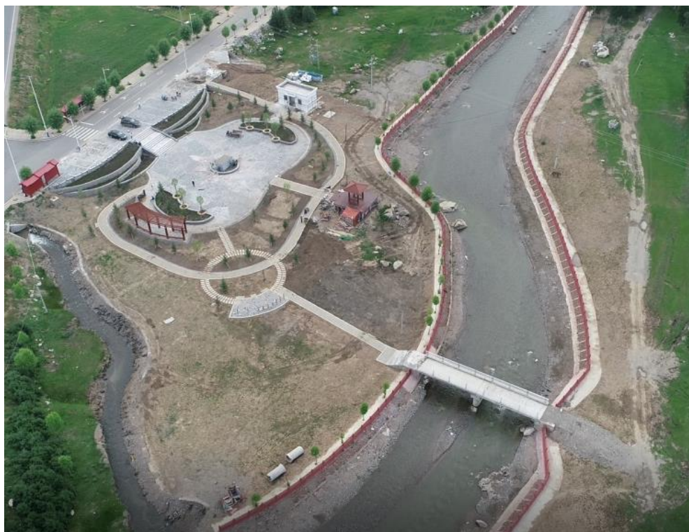
图 2-2 施工场地现状图
