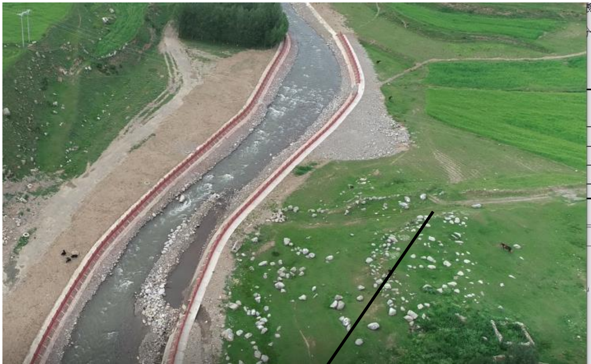
施工道路复绿现状
