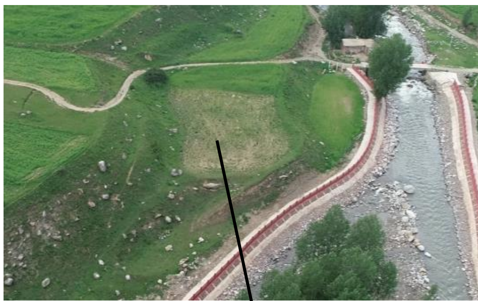
堤后回填区域复绿情况
