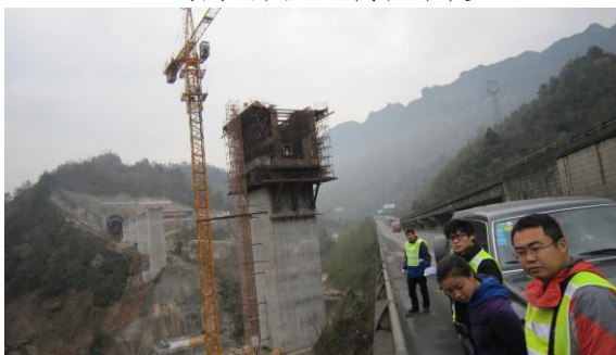
西成客专三河口大桥位于老路右侧桥墩
