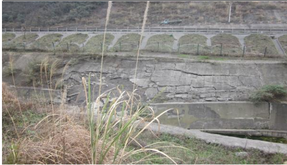
老路局部护坡损坏
