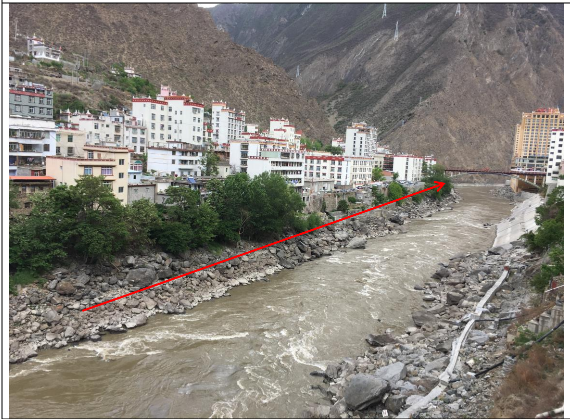
防洪堤工程建设区域现状 (Z0+829.74~Z1+270.00 段)
