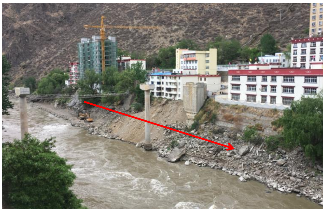
图 2.1-2 下穿三岔河北路大桥处现场照片
