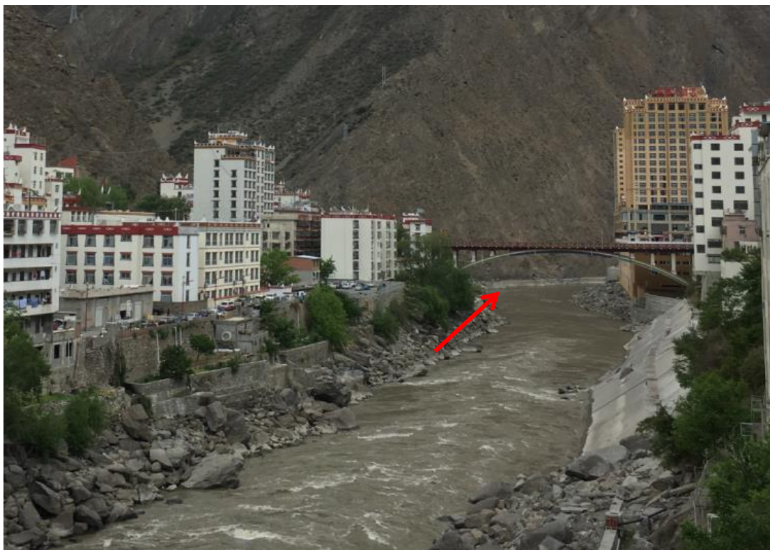
图 2.1-3 下穿丹巴大桥处现场照片
