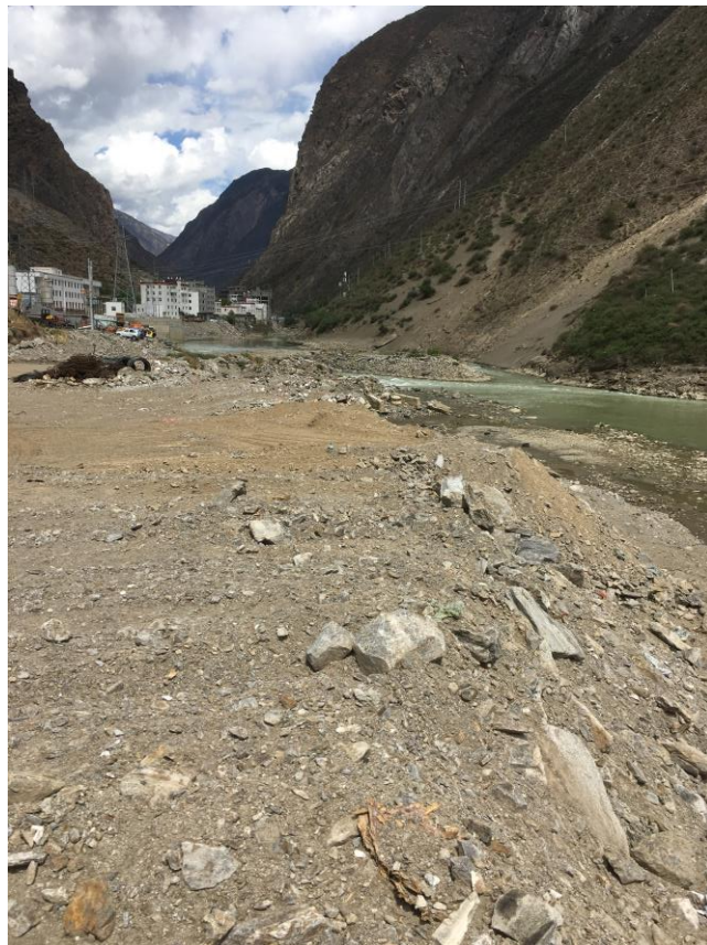
防洪堤工程终点处现状
