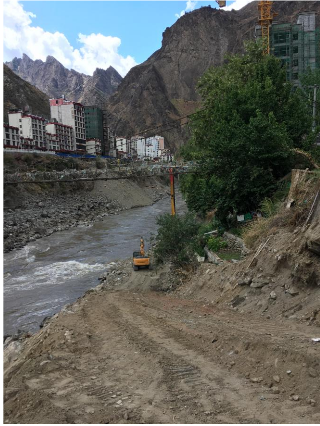
防洪堤工程起点处现状
