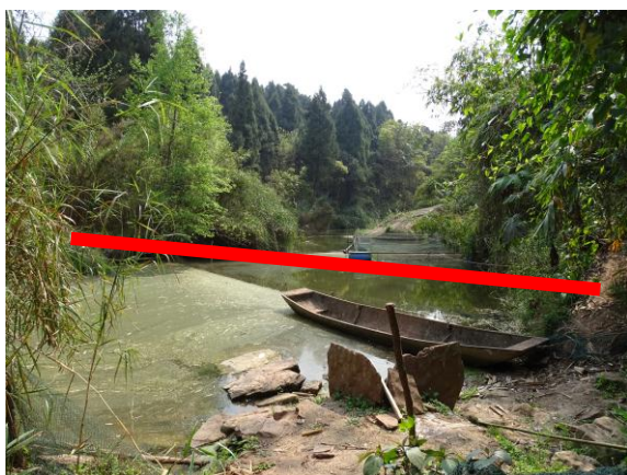
朱家冲 1#大桥 (NK18+480)
