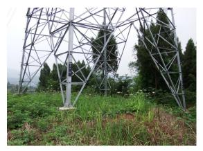
南充-蓬安 220kV 线路工程塔基内摊平余土后绿化
