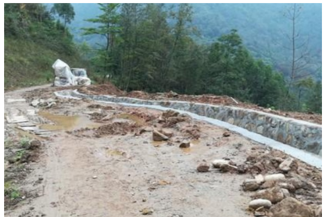
燕子山隧洞进口渣场排水
