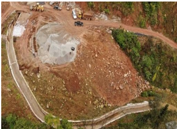
九峰山隧洞出口渣场排水
