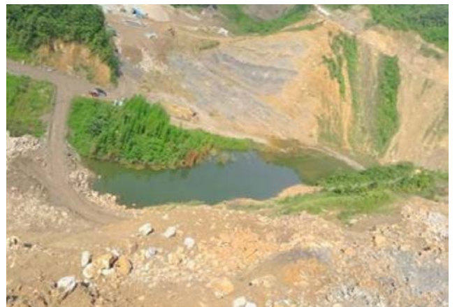
烂田沟料场开采回填区
