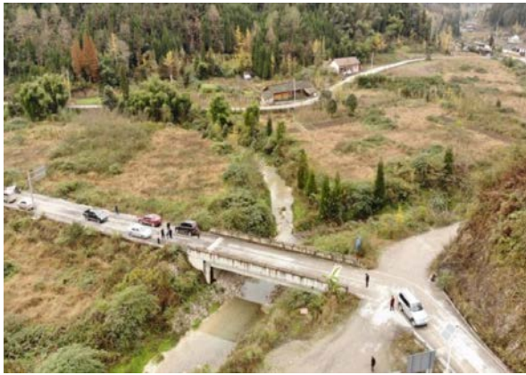
枢纽库尾渣场
