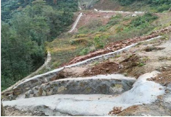
燕子山隧洞进口渣场排水
