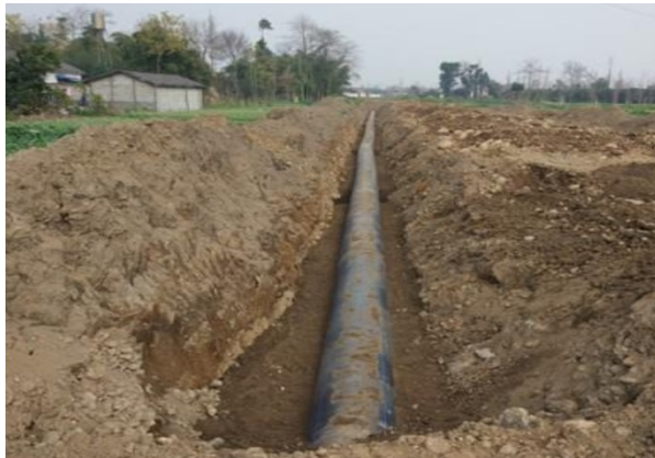
管道工程开挖
