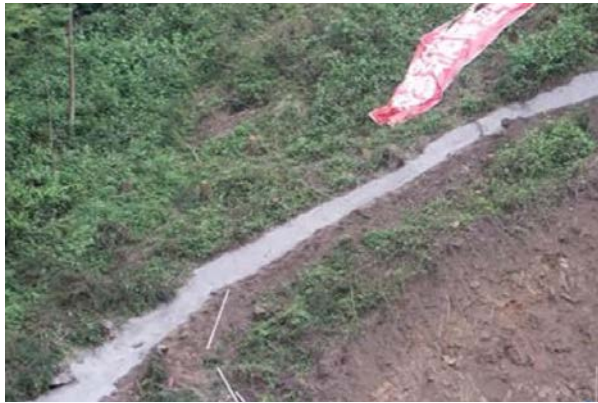
取水洞洞口临时排水沟
