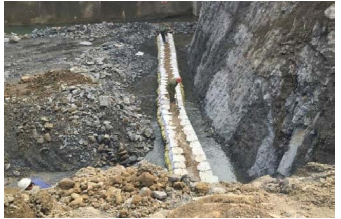
溢洪道临时排水沟
