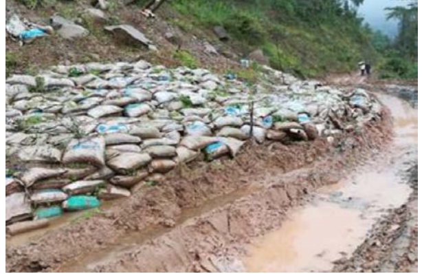
渠系区边坡临时挡护
