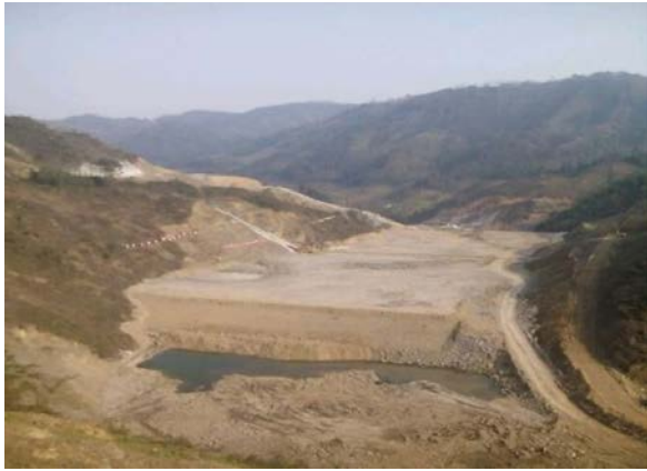
大坝主体填筑
