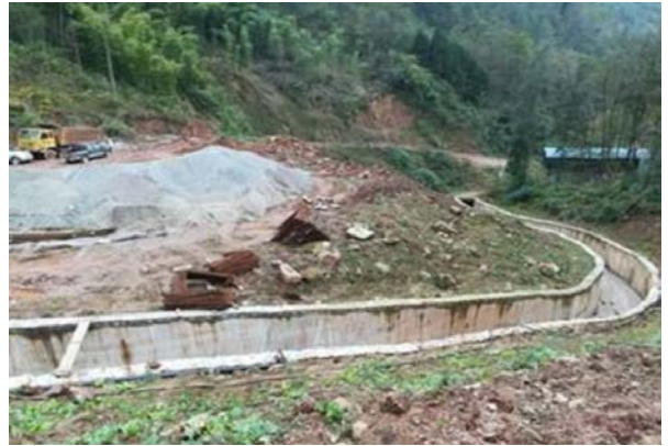
九峰山隧洞出口渣场排水
