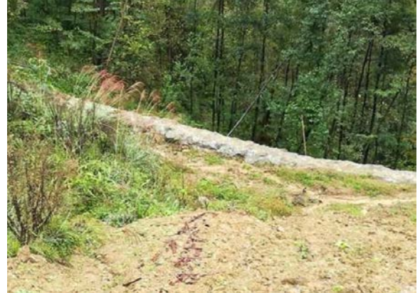
燕子山隧洞出口渣场挡墙
