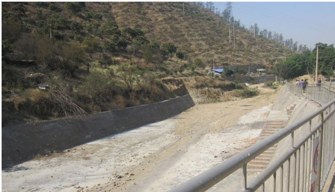
图 3.3-4 石家沟弃渣场泥石流排导槽进口上段沟道
