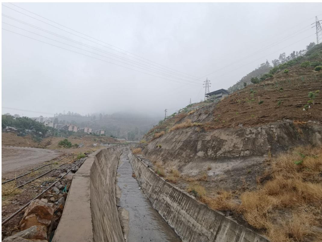
图 3.3-5 石家沟渣场泥石流排导槽
