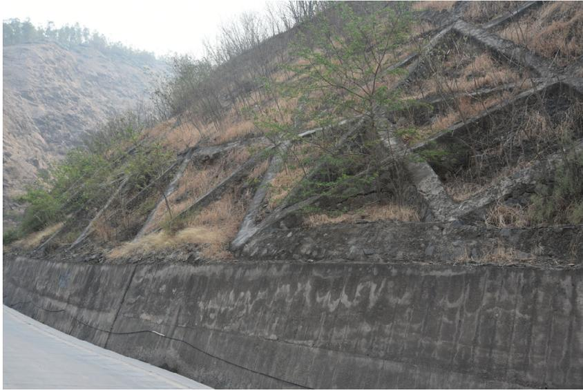
图 1.2-6 道路排水及、拦挡及边坡网格护坡
