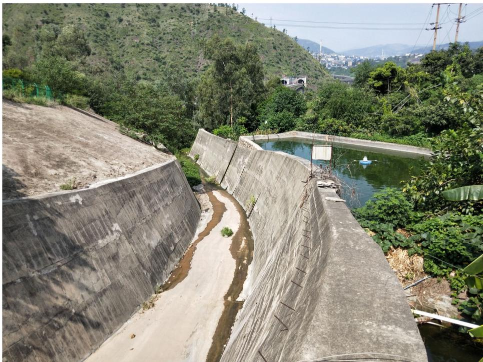
图 3.3-6 石家沟渣场泥石流排导槽出口下段沟道
