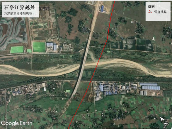
石亭江穿越处（一）
