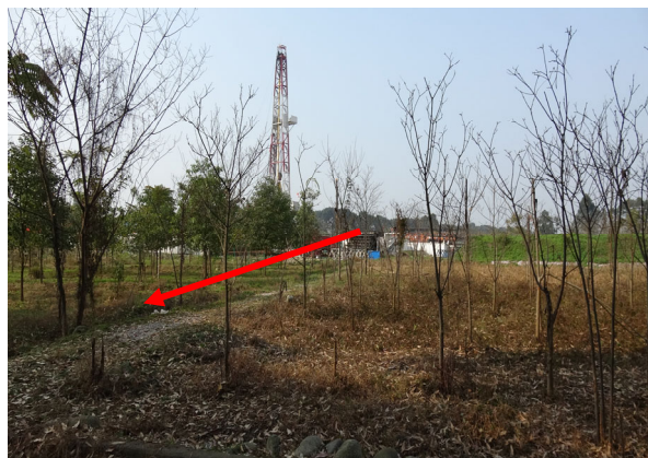
在建彭州 4 集输站及出管方向
