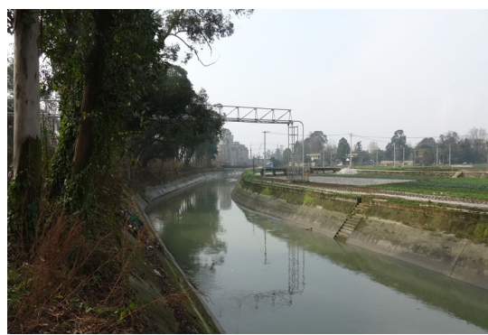
管道桁架跨越人民渠
