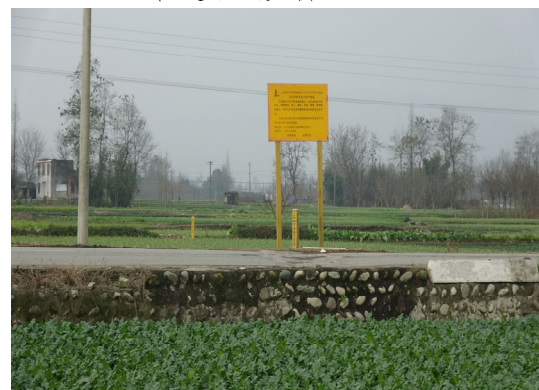
管道穿越乡村道路 (二)
