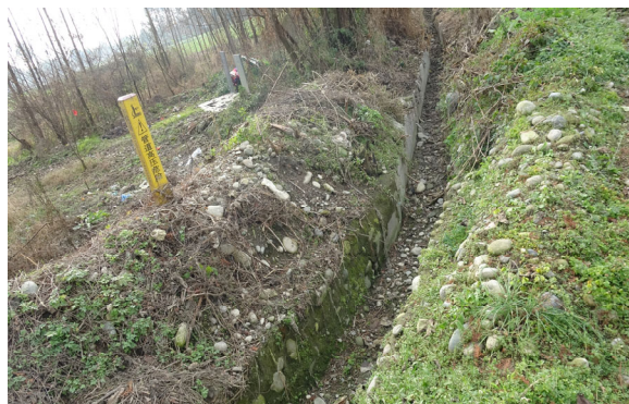
管道穿越道路及水渠
