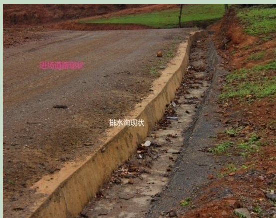
道路浆砌石排水沟
