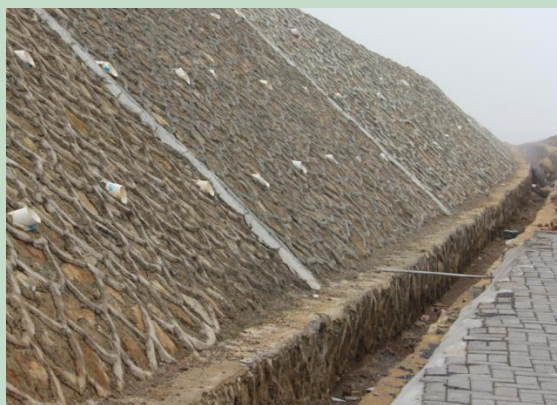
浆砌石排水沟及护坡
