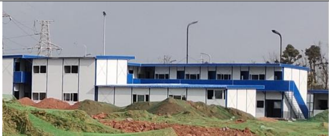
施工营地现状
