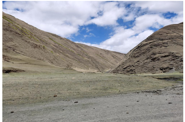
10#弃渣场新建施工便道
