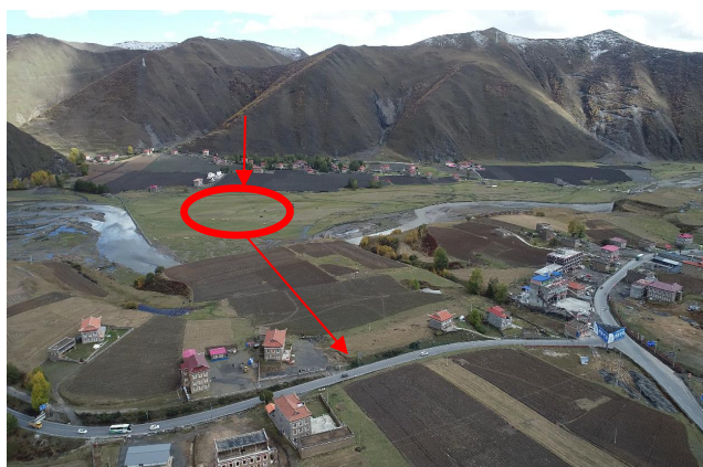
项目止点 (新都桥枢纽互通) K95+290
