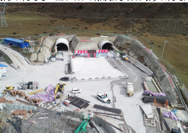
折多山隧道出口 K64+487 (利用在建 G318 折多山隧道)
