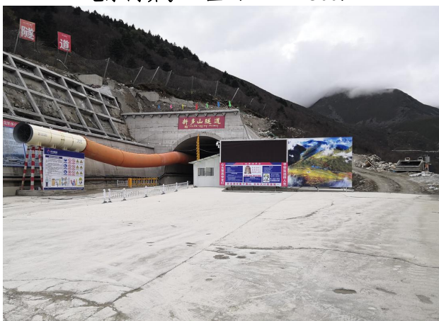
折多山隧道进口 K56+060 (利用在建 G318 折多山隧道)
