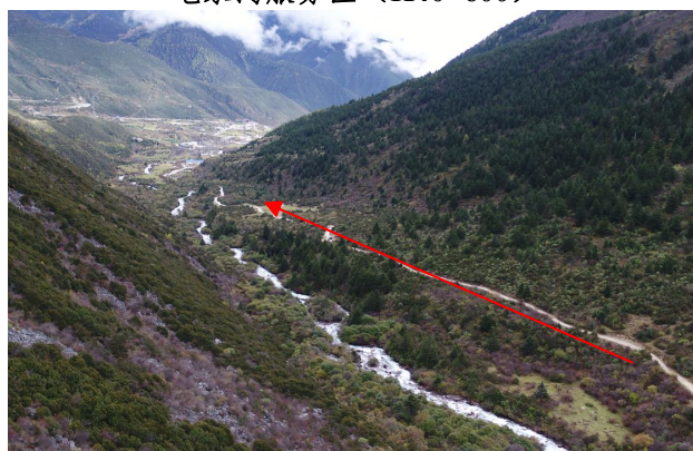
毛家沟服务区应急联络道
