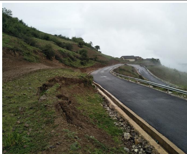
照片 2 项目区现状进场道路
