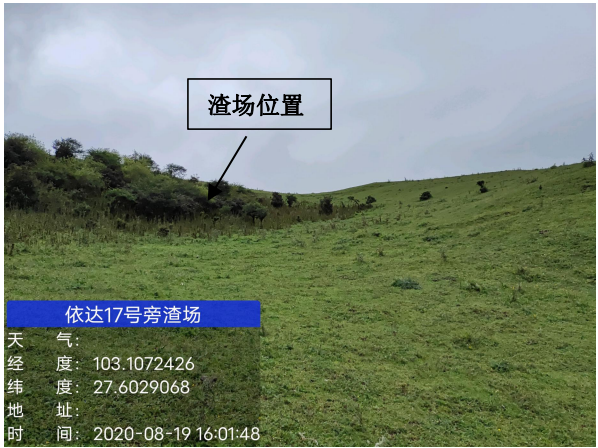
照片 14 2#渣场现状
