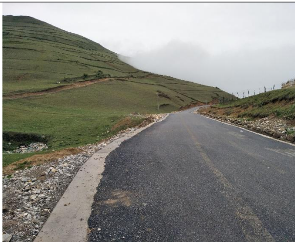
照片 3 项目区现状进场道路
