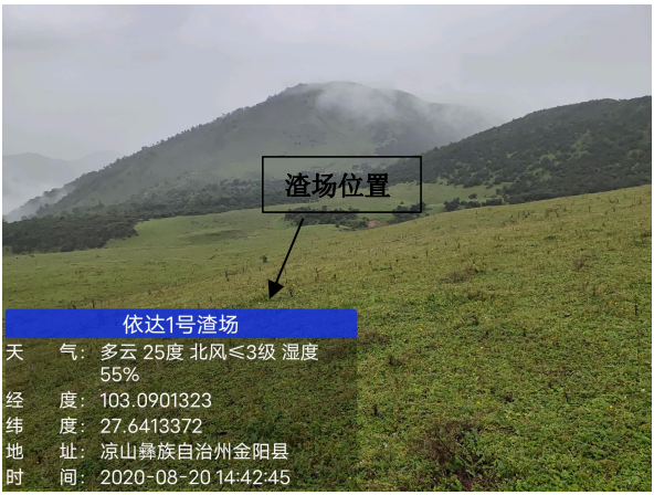
照片 13 1#渣场现状
