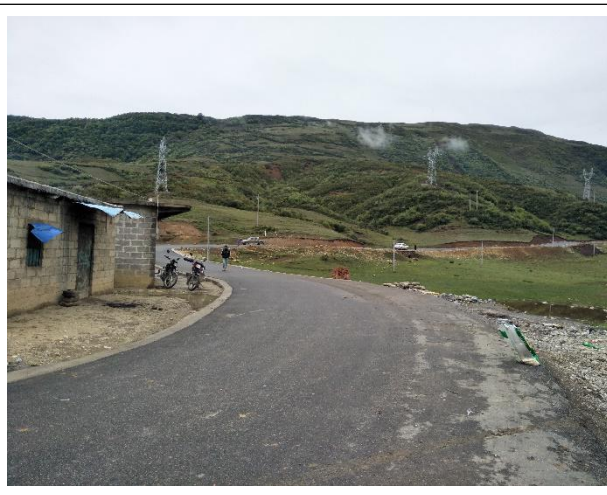
照片 4 项目区现状进场道路
